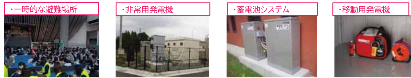
提供)東京都 出典)国土交通省第1回「道の駅」第3ステージ推進委員会 配付資料「資料4 道の駅の防災機能強化について」
