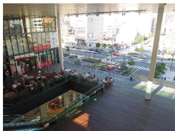
尾張一宮駅ビル （愛知県一宮市）
