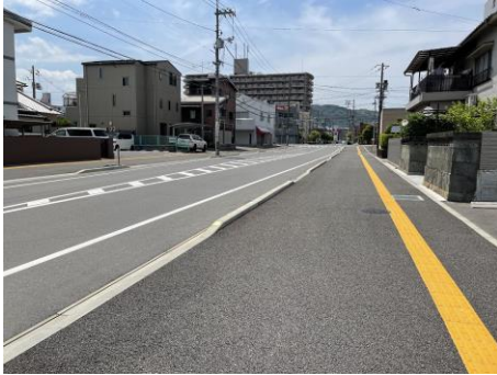
バリアフリー化された市道
