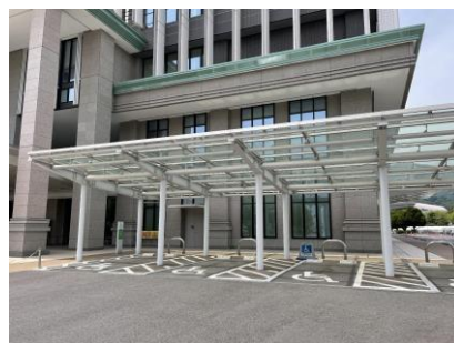
障害者用駐車区画
