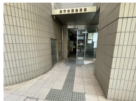
視覚障害者誘導用ブロック
