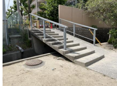
スロープ補修予定箇所（勾配調整）
