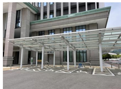
障害者用駐車区画
