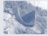
側面には水を通した溝がある
