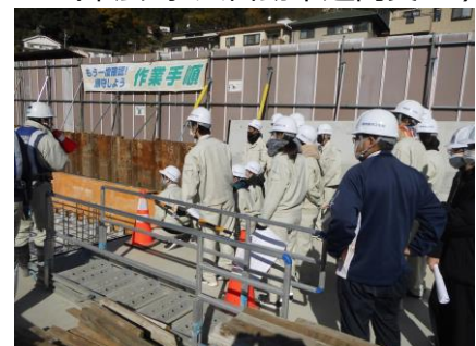
【地元学生を対象とした工事現場見学会 (東広島・呉自動車道阿賀 IC)】
