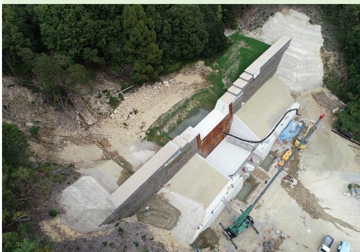
砂防ダム(中ヶ原川)
