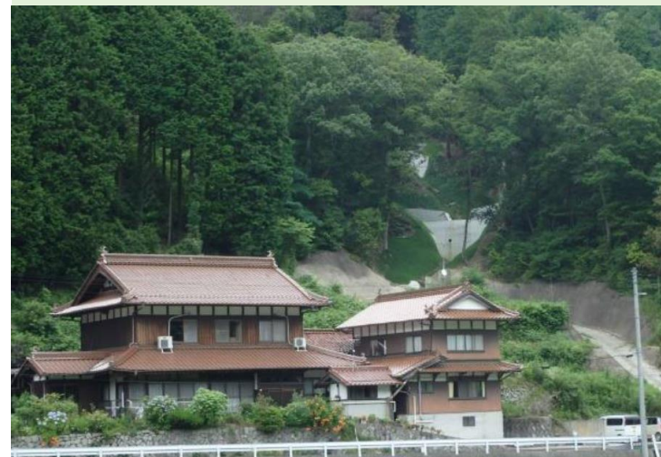
治山ダム(中山地区・2基)
