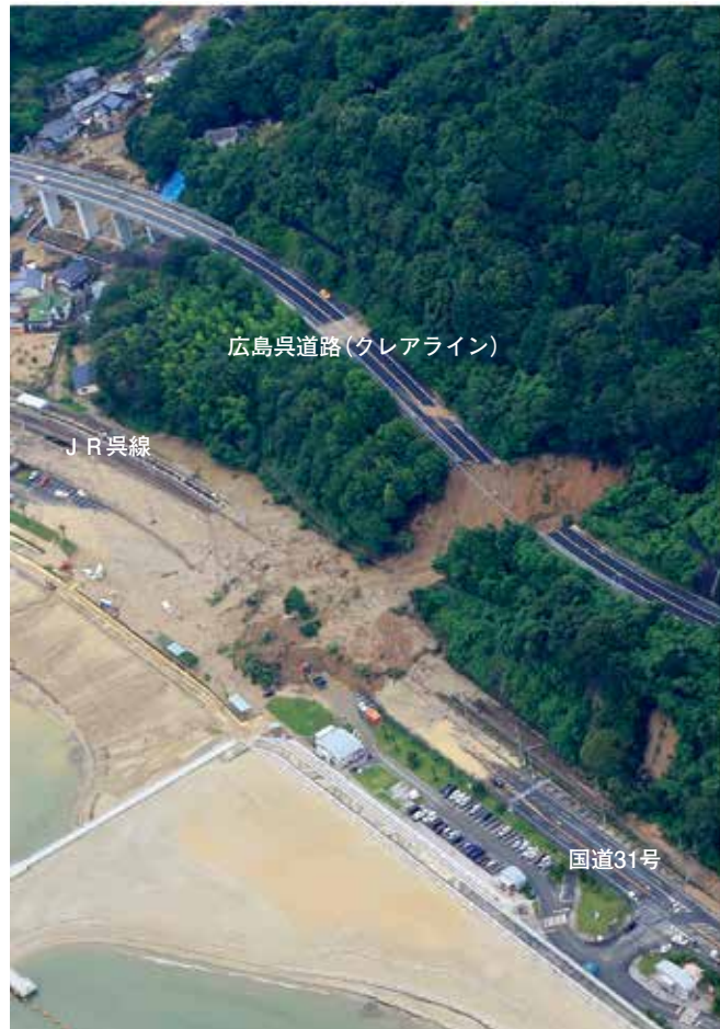
被災した広島呉道路と土砂により埋塞されたJR呉線・国道31号(坂町水尻:7/7撮影)
