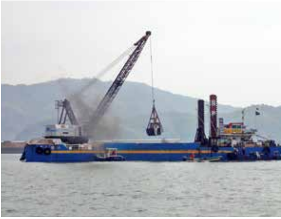
浚渫工事(阿賀地区・黒瀬川河口)
