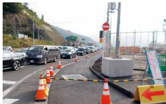
東広島・呉自動車道 阿賀IC出口に設置された供用開始間近の左折レーン(7/28撮影)
