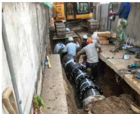
緊急時用連絡管の布設状況 (広多賀谷・8/12撮影)
