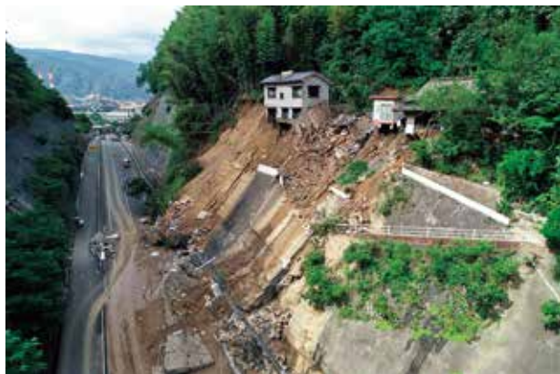
広仁方停車場線の斜面崩落により、仁方・戸田地区から広・長浜地区にかけて一時孤立する状況となった。 広・津久茂側での斜面崩落状況(写真左)と仁方・戸田側での崩土の堆積状況(写真右)(いずれも7/9撮影)
