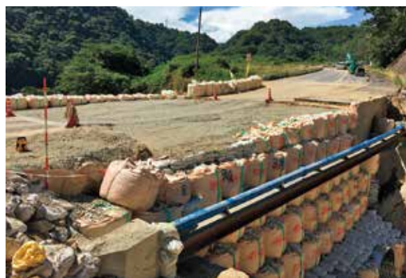
広石内地区配水管の仮配管(国道375号上段原橋)
