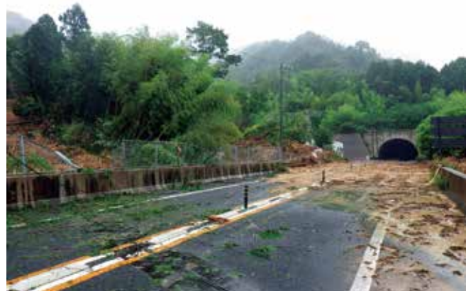
路面へ土砂が流入した東広島・呉自動車道(岩山トンネル黒瀬側:7/8撮影)
