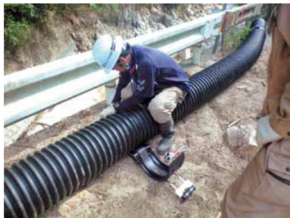
市職員による天応焼山污水幹線の仮配管状況
