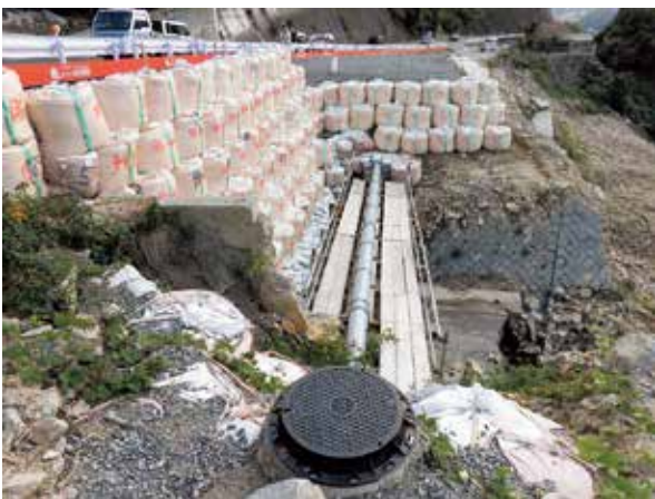
石内郷原污水幹線の仮配管(国道375号上段原橋)
