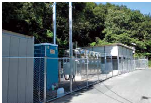
柳迫第1ポンプ所に代わり設置した仮設ポンプ所
