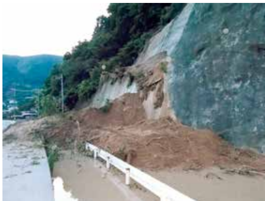
広仁方停車場線の斜面崩落により、仁方・戸田地区から広・長浜地区にかけて一時孤立する状況となった。 広・津久茂側での斜面崩落状況(写真左)と仁方・戸田側での崩土の堆積状況(写真右)(いずれも7/9撮影)
