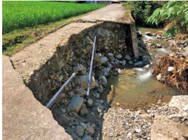
安浦・女垣内集落へ連絡する市道の被災状況
