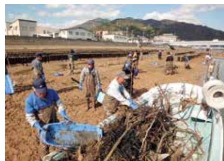
堆積物等撤去作業(広地区・黒瀬川河口)
