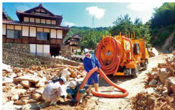
マンホールからの土砂吸引作業(安浦地区)
