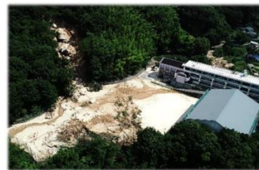
【被災した天応中学校】
