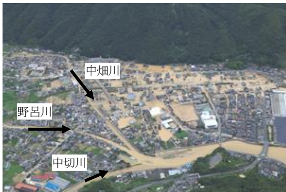
【安浦地区の浸水被害(平成30年7月7日)】
