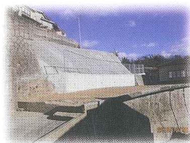
西畑町急傾斜地崩壊対策事業
