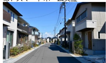
人と建物の健康をサポートする IoT スマートホーム実証
