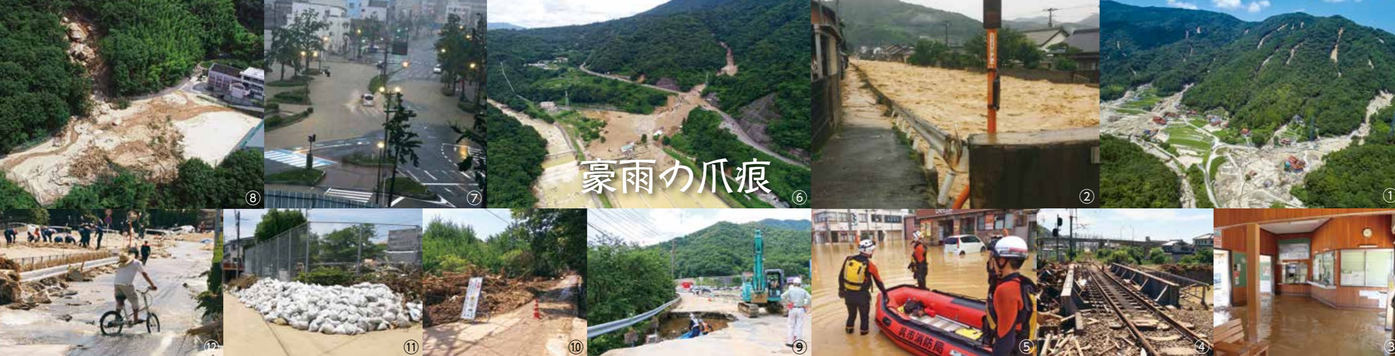
⑥土石流により不通となった国道375号 ⑦冠水した市役所前 ⑧土砂がグラウンドを覆った天応中学校 ⑨道路が崩落した国道185号 ⑩道路復旧中の昭和地区押込 ⑪土のうが積まれた昭和地区第三団地 ⑫道路に水が流れる天応西条
