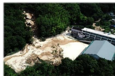
【被災した天応中学校】
