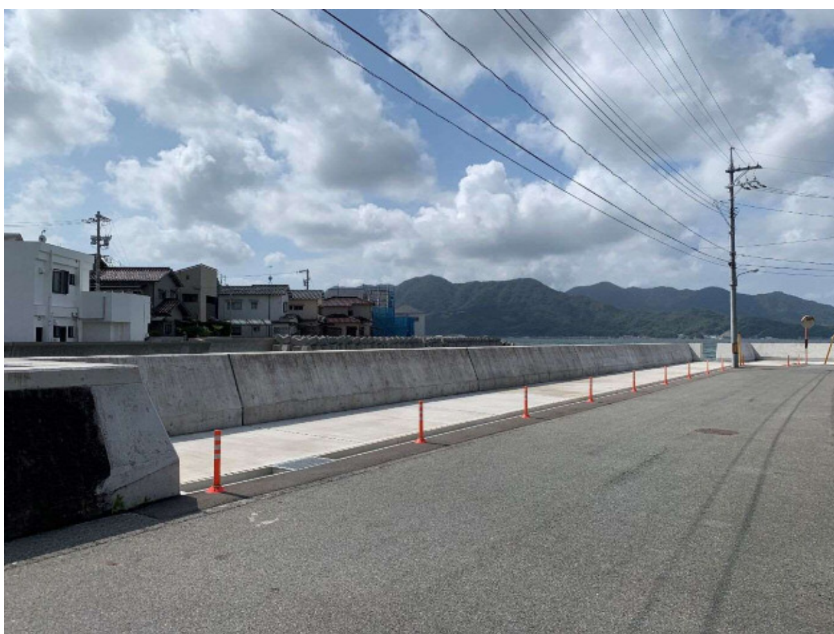
大屋大川河口部にて整備を進めている広島県の海岸事業
