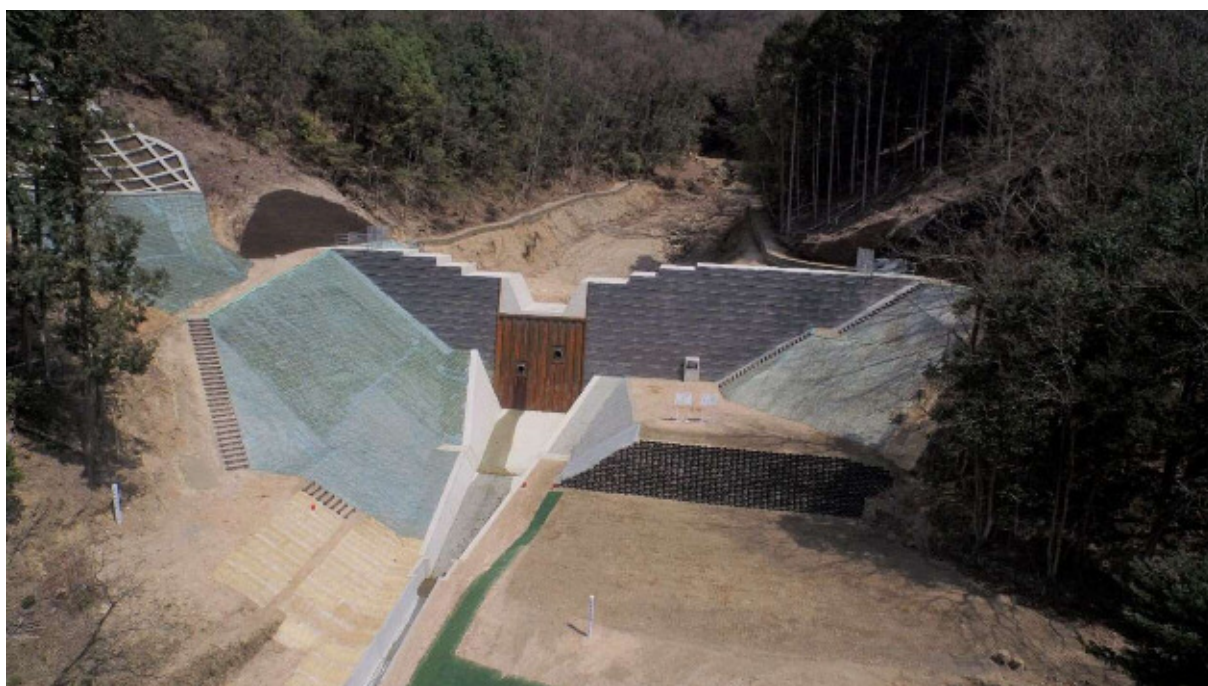
広島市安佐北区高谷に整備された砂防ダム（平成28年3月竣工）
