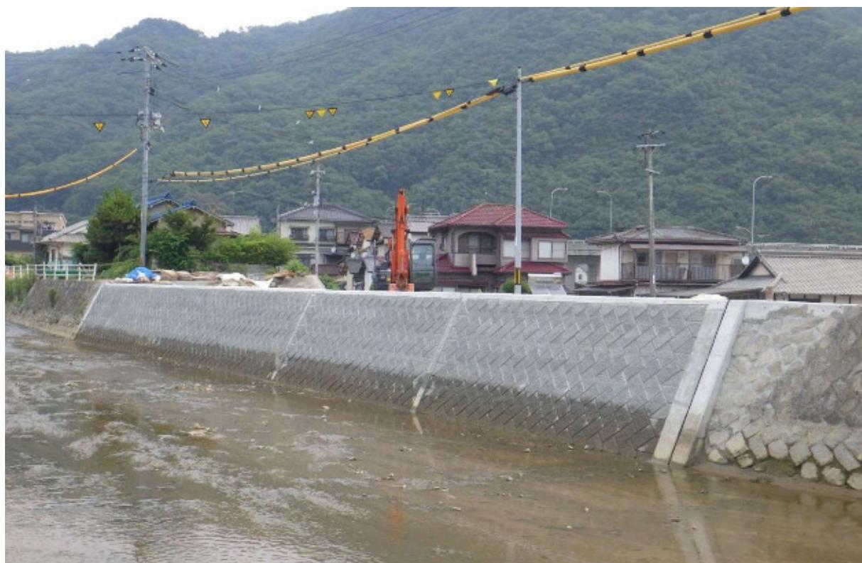
破堤した中畑川護岸の復旧状況（八千代橋付近）
