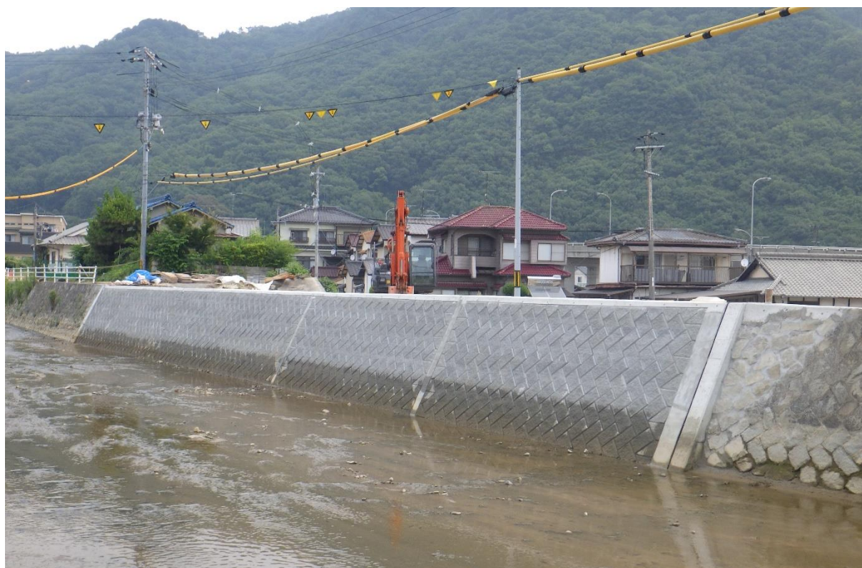
破堤した中畑川護岸の復旧状況（八千代橋付近）
