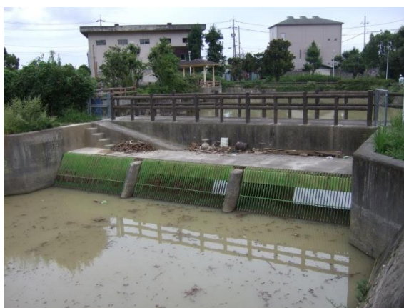
▲月見公園ポンプ場（遊水池入口）
