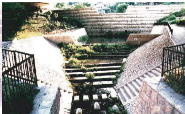
▲地域景観に配慮した堰堤整備
