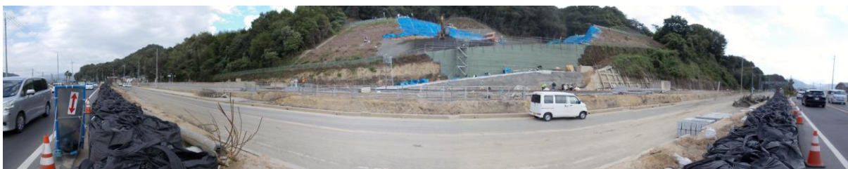
広島呉道路の復旧工事の状況（安芸郡坂町水尻）
