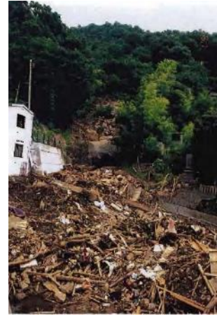
被災地より崩壊斜面部を眺める
