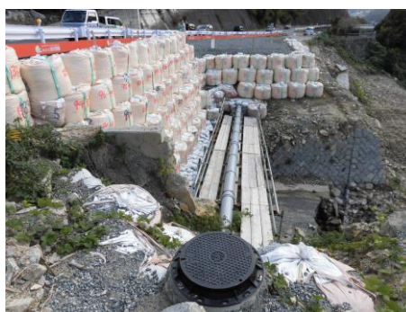
被災した下水道管を仮配管により復旧（国道375号上段原橋）
