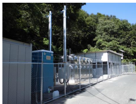
全壊した柳迫第1ポンプ所に 代わり仮設ポンプ所を設置
