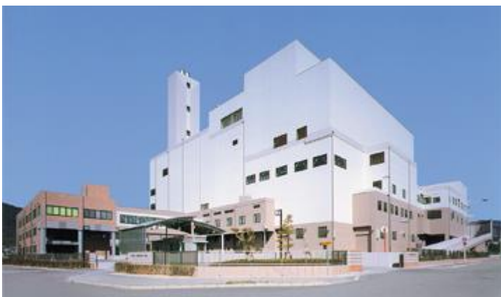
クリーンセンターくれ
