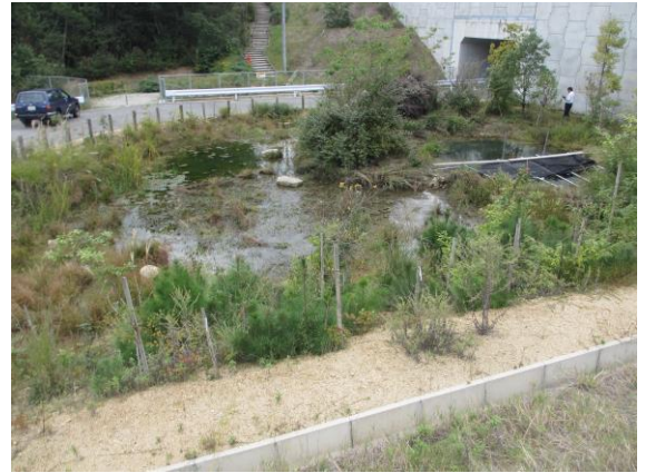
エコ・グローブくれ（呉市一般廃棄物最終処分場）のビオトープ
