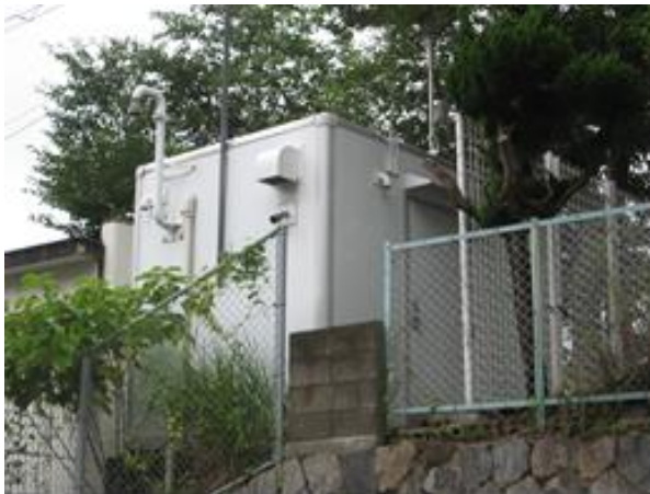
明立小学校大気測定局（中央地区）
