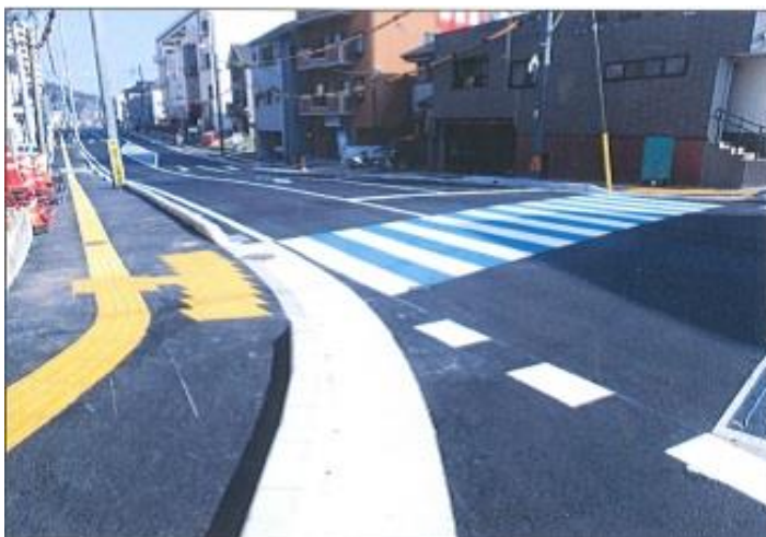
視覚障害者誘導ブロック設置
