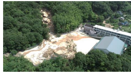
天応中学校の被災状況
