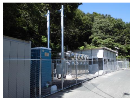
全壊した柳迫第1ポンプ所に 代わり仮設ポンプ所を設置
