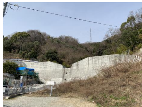
平成29年に完成した砂防ダム (広横路2丁目)
