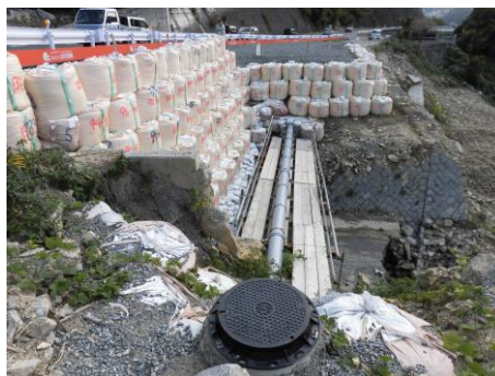
被災した下水道管を仮配管により復旧（国道375号上段原橋）
