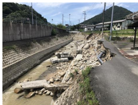
被災した市道東麻畠梶耶線と二級河川中切川
