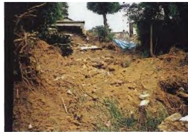
被災人家より見た斜面状況
