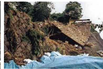
土砂により押しつぶされた被災人家
