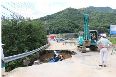
国道185号（仁方町）
