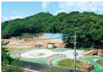
工事中の呉市営プール
