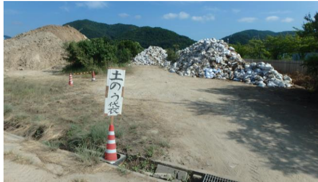
住民用仮置場（実成下水処理場）
