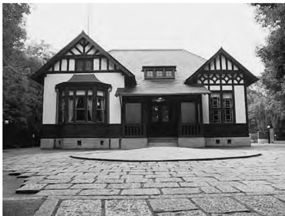
【呉市入船山記念館（国重要文化財「旧呉鎮守府司令長官官舎」）】 呉市入船山記念館所蔵
