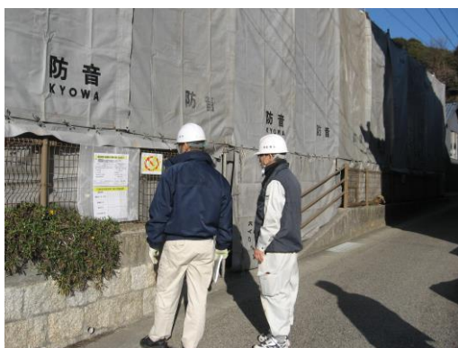
アスベスト排出等作業の掲示板の確認
