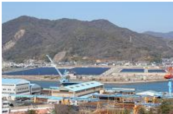
(寺田倉庫 7,000kW 安浦)
