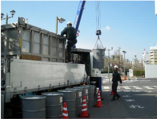
PCB 廃棄物の搬出状況
