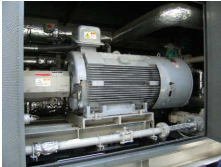
空気熱源ブラインヒートポンプチラー
