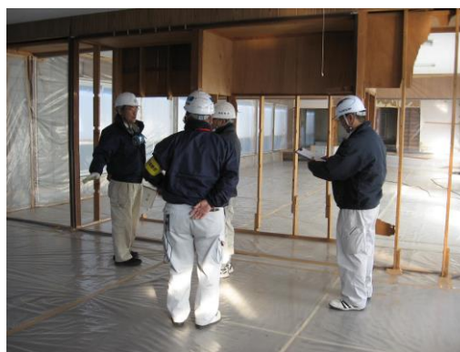
アスベスト排出等作業前の養生検査
