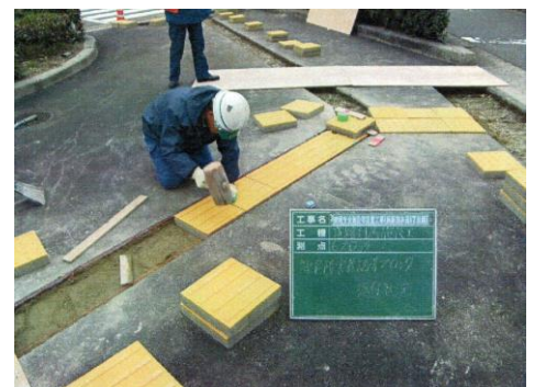
視覚障害者誘導ブロック設置
