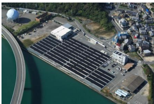
(広島ガス 733kW 阿賀)
