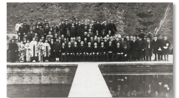
▲三永水源地から平原浄水場への着水記念(平原浄水場にて)(昭和18年2月)
