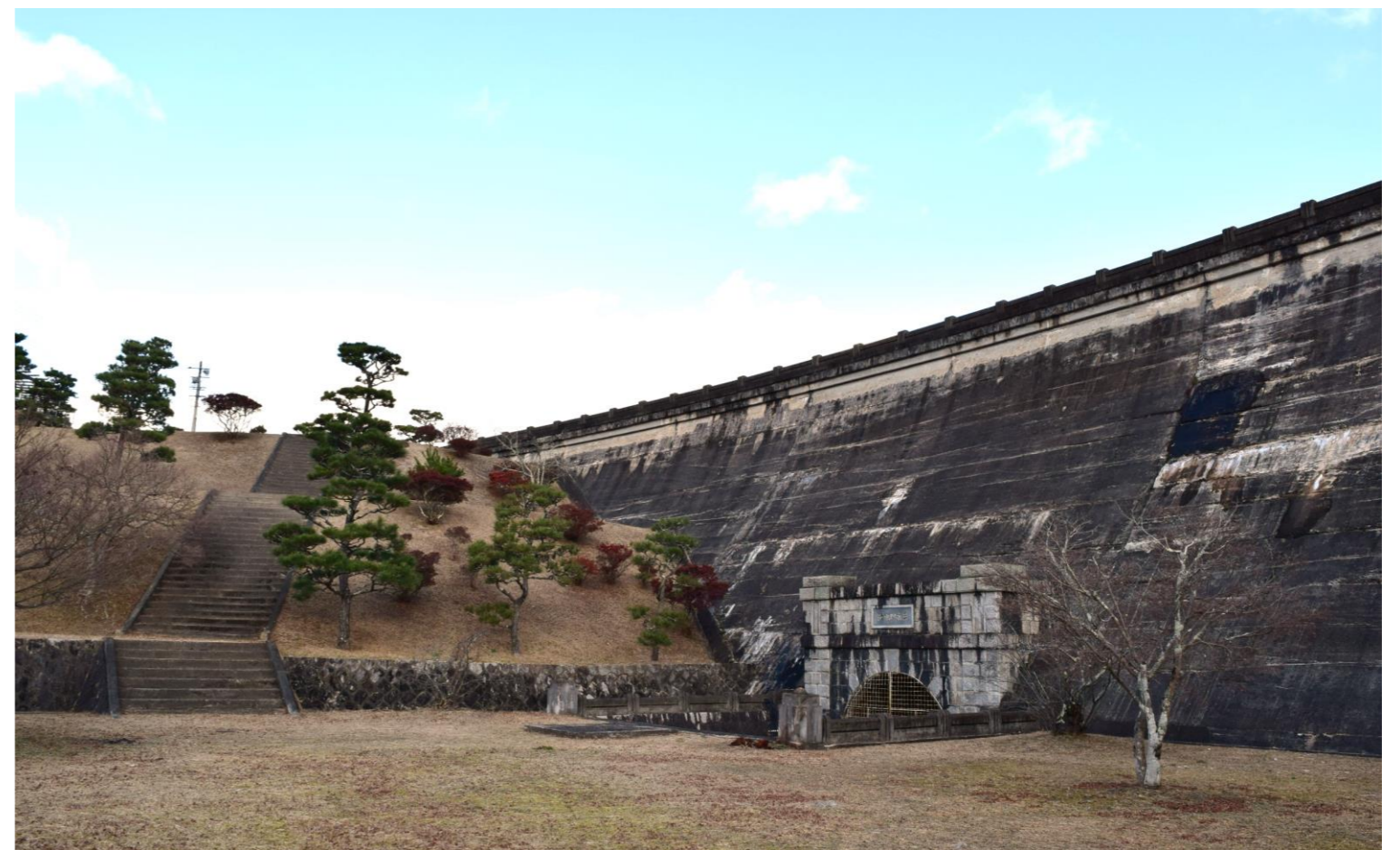
▲現在の三永水源地堰堤
