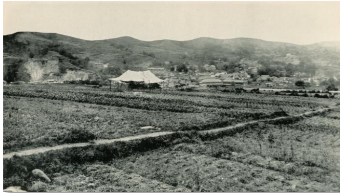
▲平原浄水場の起工式(大正4年7月)
