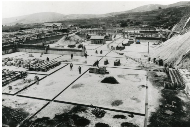
▲平原浄水場緩速ろ過池築造工事(大正7年頃)
