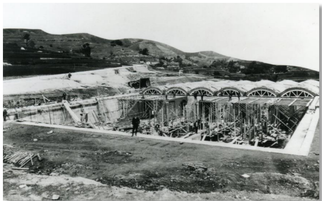
▲平原浄水場低区配水池築造工事(大正6年)
