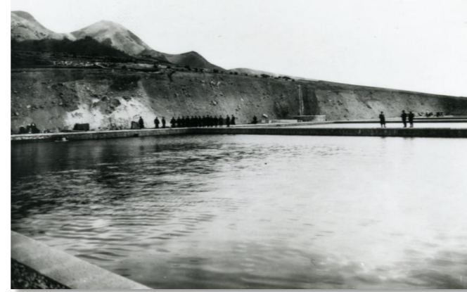
▲平原浄水場緩速ろ過池(大正7年3月完成)
