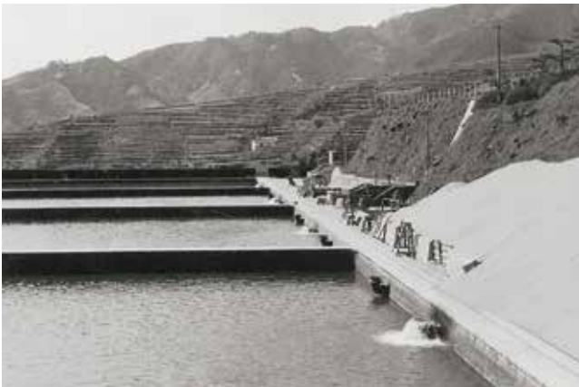
第3期拡張事業着工の頃(昭和30年)
