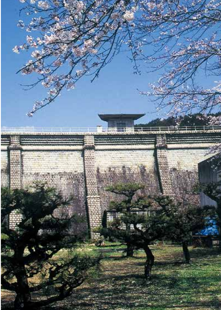
本庄水源地堰堤
