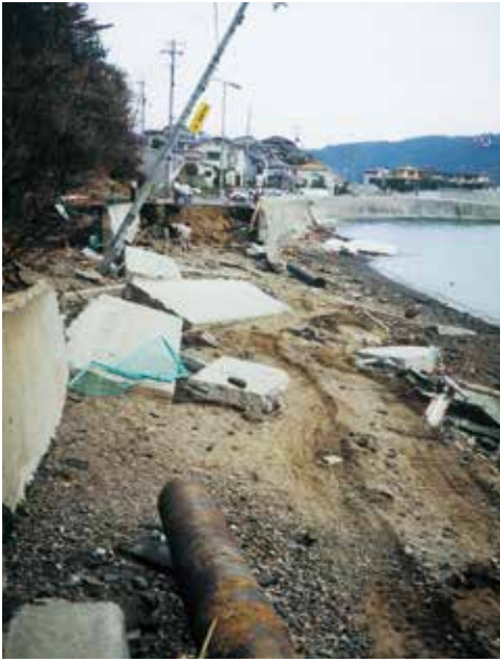
護岸・道路と共に配水管も削り取られている(平成3年)
