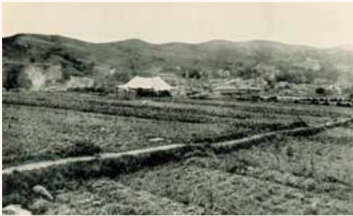
平原浄水場の起工式(大正4年7月)
