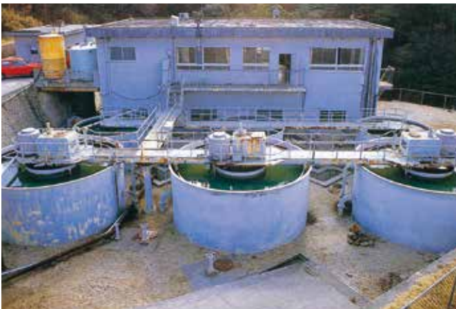
稼働時の焼山浄水場
