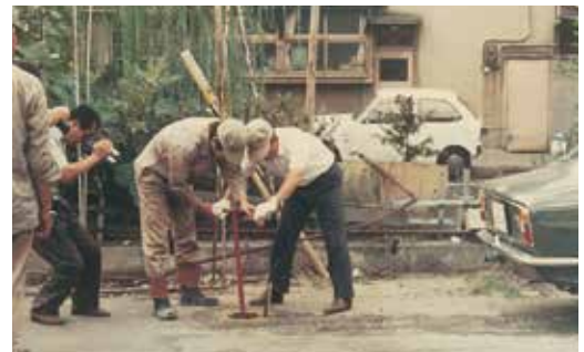
隔日給水のためのバルブ操作(昭和48年)
