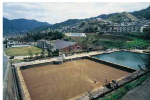
宮原浄水場緩速ろ過池(平成20年撤去)と低区配水池(平成6年頃)
