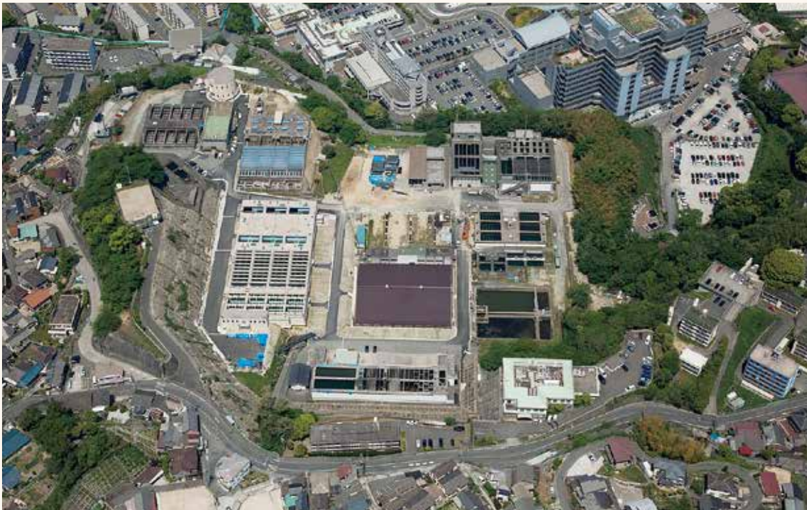
平成25年の宮原浄水場 左上部は円筒形の新導水ポンプ所, 左中部は新浄・配水施設
