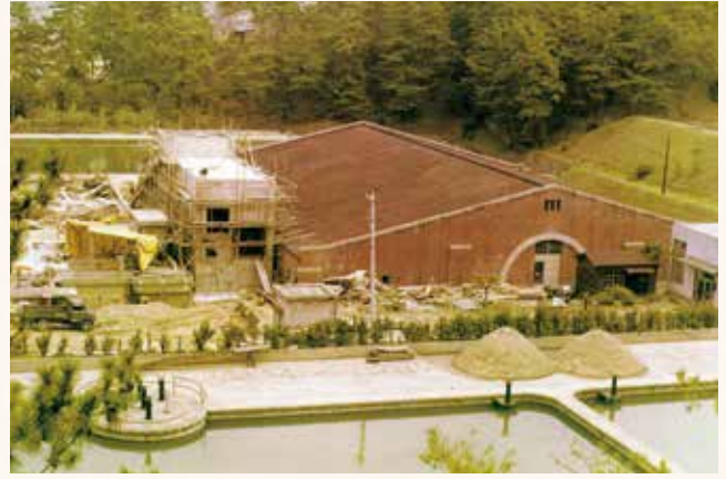
宮原浄水場内：広島水道用水供給事業との共同施設（低区配水池の横の中区ポンプ所）を建設（昭和47年）
