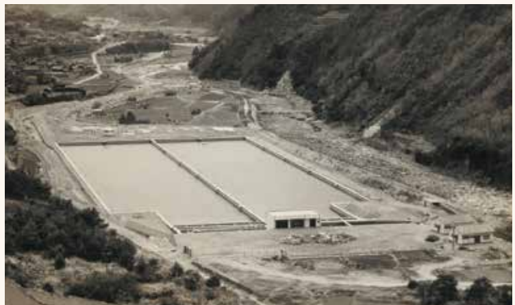
完成当時の二級水源地
