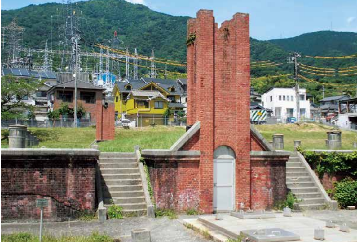
平原浄水場低区配水池
