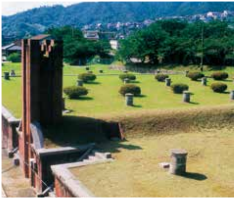
平原浄水場低区配水池
