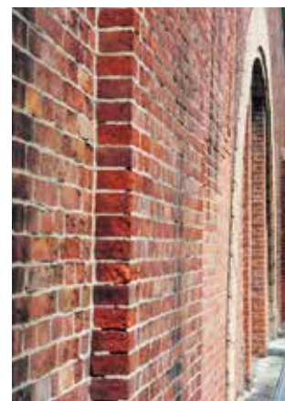
宮原浄水場低区配水池横から
