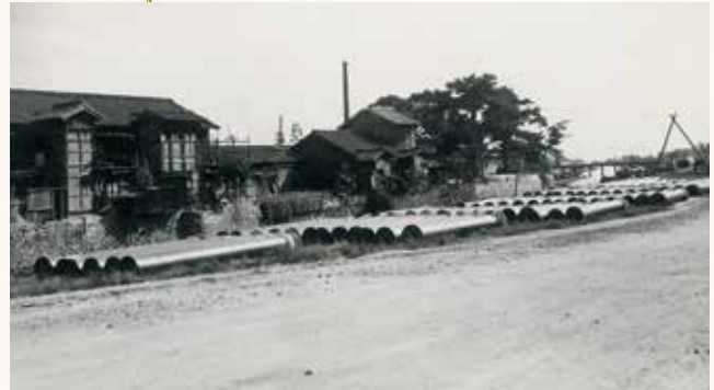
越畑線布設工事(昭和27年頃)
