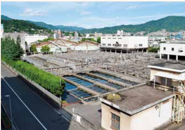
下水道事業の主な施設：新宮浄化センター
