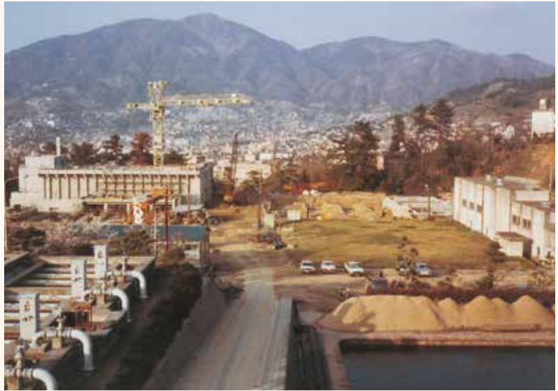
宮原浄水場の一角で建設工事が進む県営宮原浄水場(昭和55年頃)
