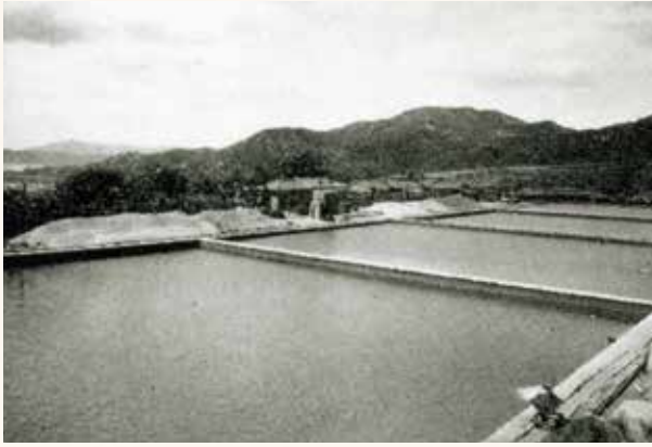
終戦後の水道施設(平原浄水場)〈昭和29年〉
