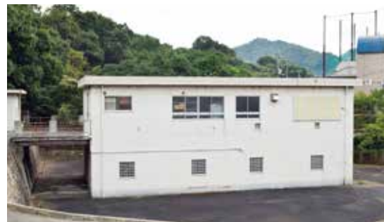
現在は焼山ポンプ所として稼働
