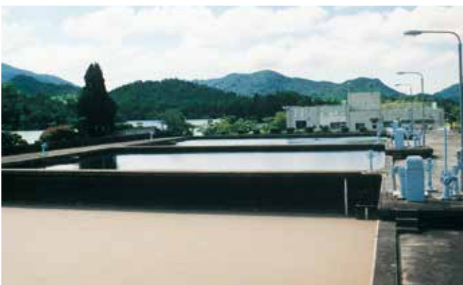
稼働時の本庄浄水場(平成15年)
