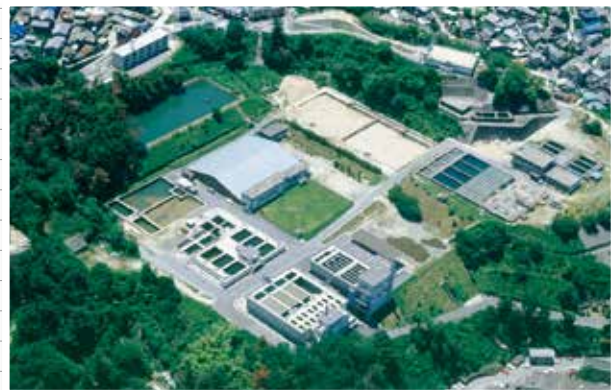
中央下部に県営宮原浄水場が完成している
