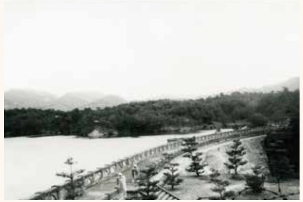
終戦後の水道施設(三永水源地)〈昭和29年〉
