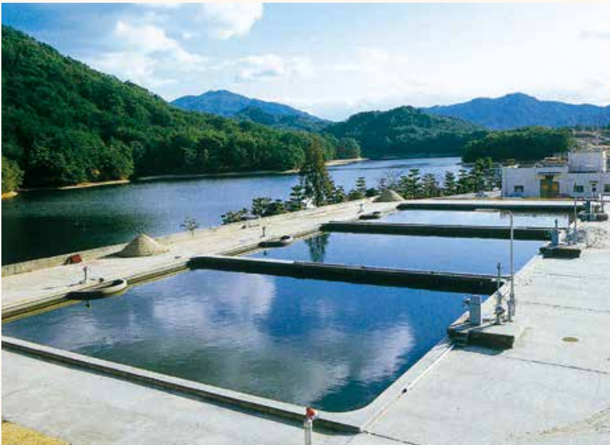
昭和61年頃の本庄浄水場(昭和56年完成)
