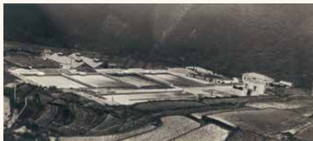
終戦後の水道施設(石内浄水場)〈昭和25年〉
