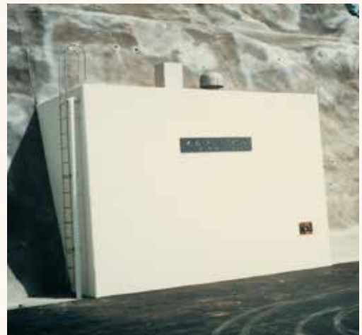
本庄隧道配水池西側坑口
