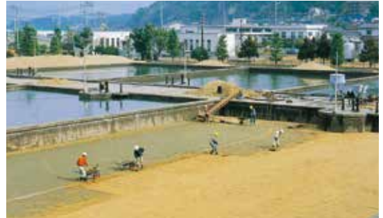
緩速ろ過池すきとり作業の様子(昭和50年代)
