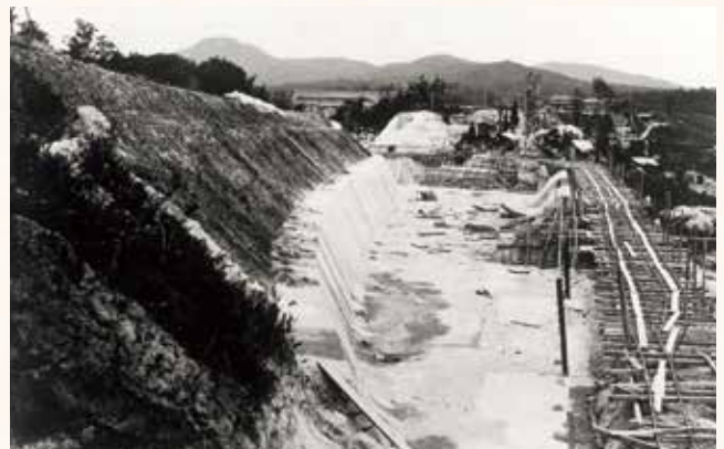
溢流堤築造工事(昭和17年5月)
