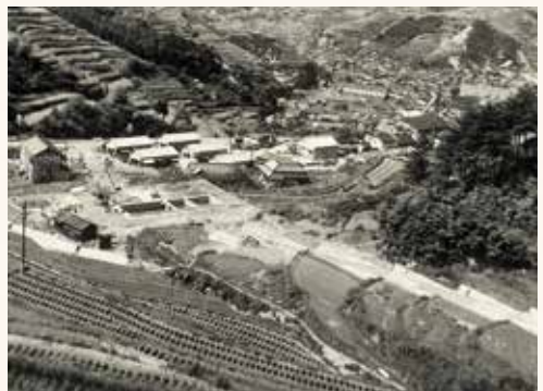
越畑減圧井建設工事(昭和27年頃)
