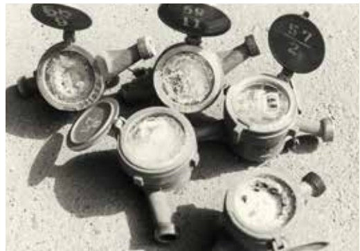
結氷によりガラス部が割れた水道メータ
