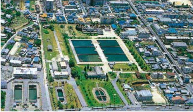
昭和50年代後半の戸坂浄水場
