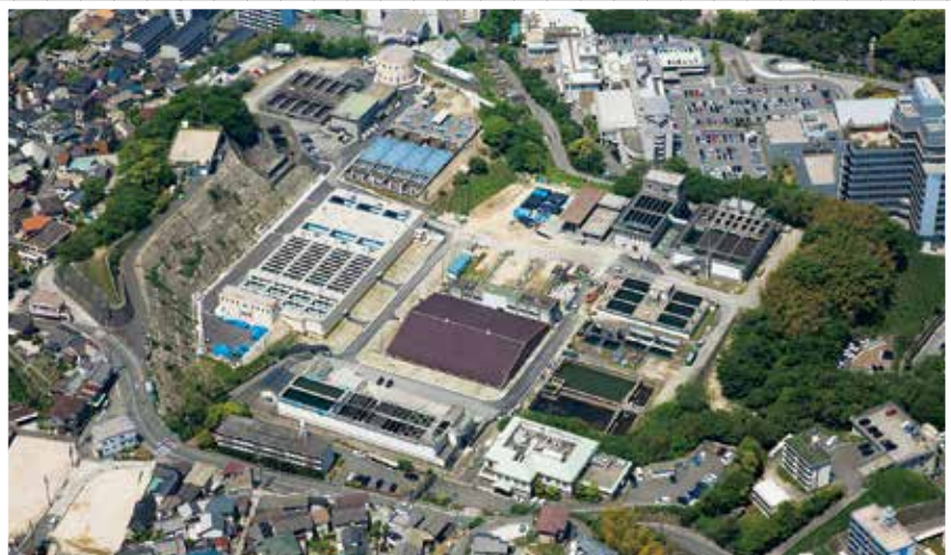
中央上部に円筒形の新導水ポンプ所が、左中部に新浄・配水施設が完成している
