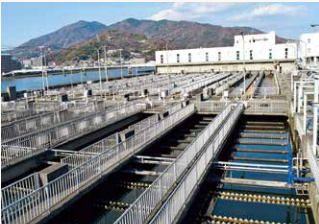
下水道事業の主な施設：広浄化センター
