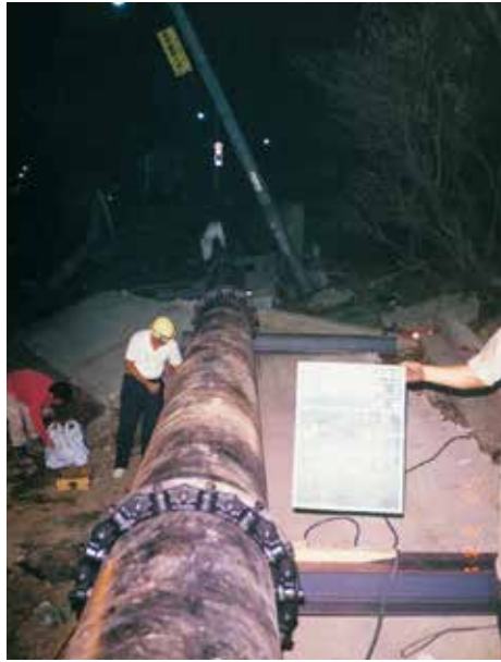
昼夜を問わず進められた復旧工事(平成3年)
