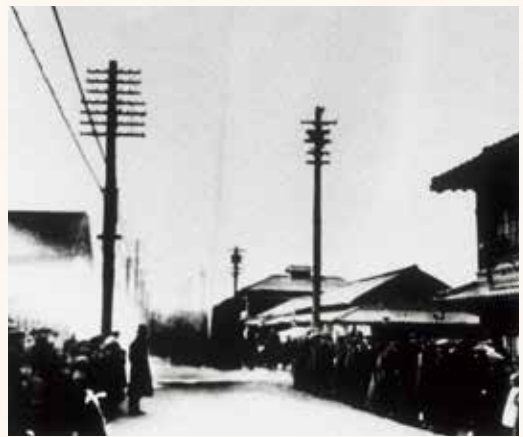
大正6年最初の水圧試験(平原浄水場通水)
