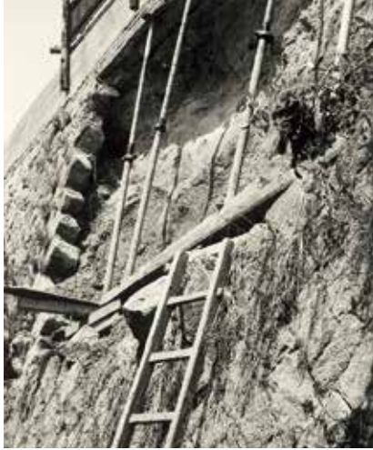
漏水した水が法面を洗い流す
