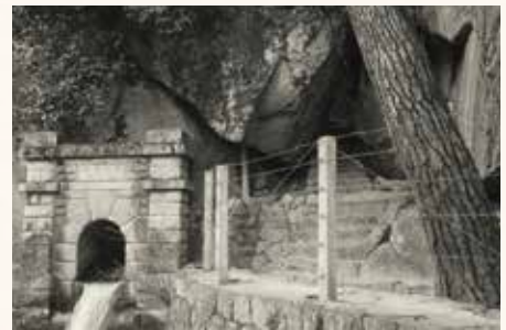
呉鎮守府水道：二河水源地
