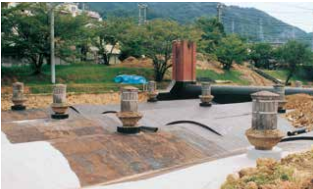
平原浄水場低区配水池補修のため上部の土を取り除いた(平成13年)
