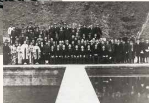
三永水源地から平原浄水場への着水記念 (平原浄水場にて)(昭和18年2月)
