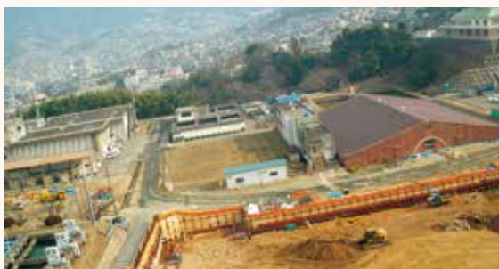
宮原浄水場内：新浄・配水施設の敷地造成工事(平成21年3月)
