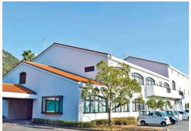
下水道事業の主な施設：天応浄化センター
