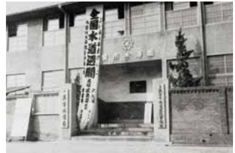
昭和34年水道局庁舎正面
