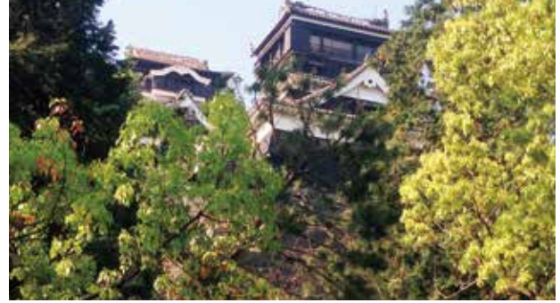
天守閣の屋根瓦が落下した熊本城(平成28年)
