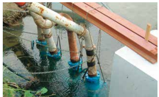
応急復旧対策(二河川から仮設ポンプによる緊急取水)(平成18年)
