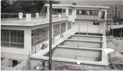
平原浄水場管理棟と急速ろ過池建設工事(昭和39年頃)
