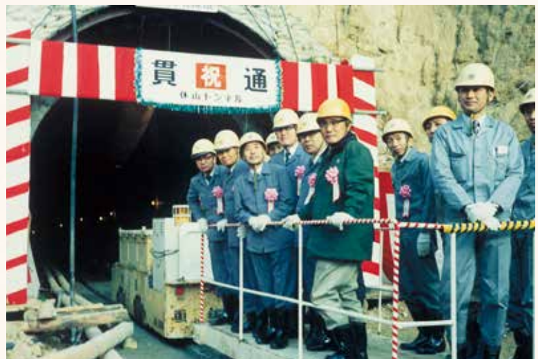
休山隧道配水池貫通式(昭和47年12月25日)
