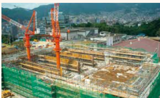
宮原浄水場内：新浄・配水施設の建設工事(平成22年9月)
