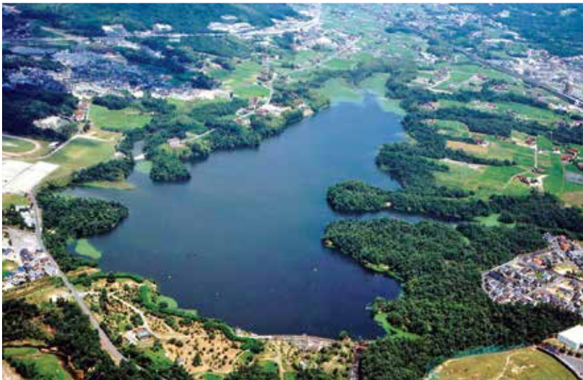
右下部の住宅団地に家屋が建ち並んでいる
