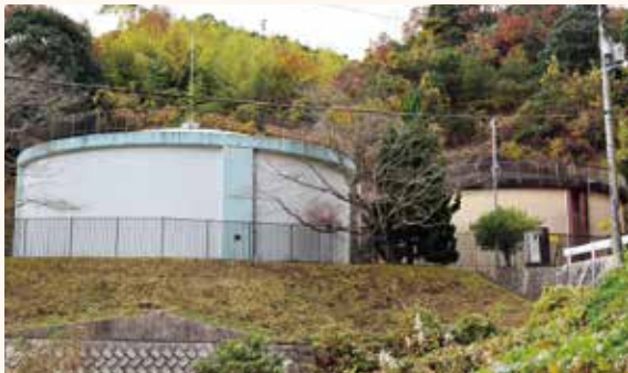
⑥安浦町：原垣内配水池
