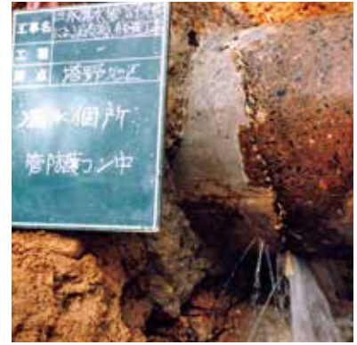
三永導水管破損による漏水の状況(平成13年)
