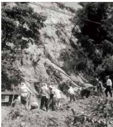
平原浄水場法面崩壊現場(昭和42年)
