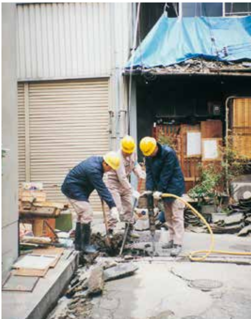
神戸市内で給水管の復旧作業に従事する呉市職員(平成7年)
