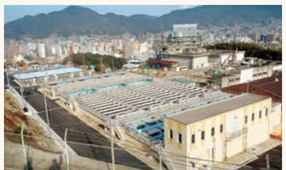
宮原浄水場内：新浄・配水施設(平成25年3月完成)
