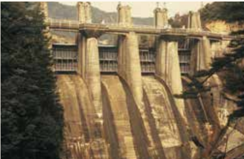
二級ダム(昭和18年完成)の発電放流水から、1日最大50,000m 3 を二級水源地に導水し、工業用水道に使用している。
