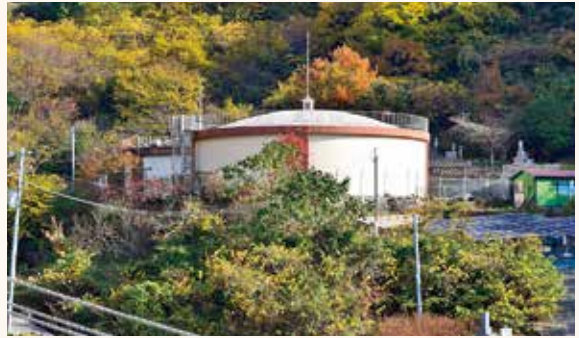
④倉橋町：本浦配水池
