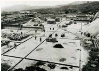
平原浄水場緩速ろ過池築造工事(大正7年頃)
