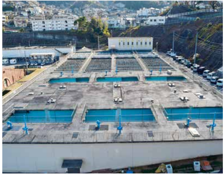
施設を統廃合し建設した宮原浄水場新浄・配水施設
