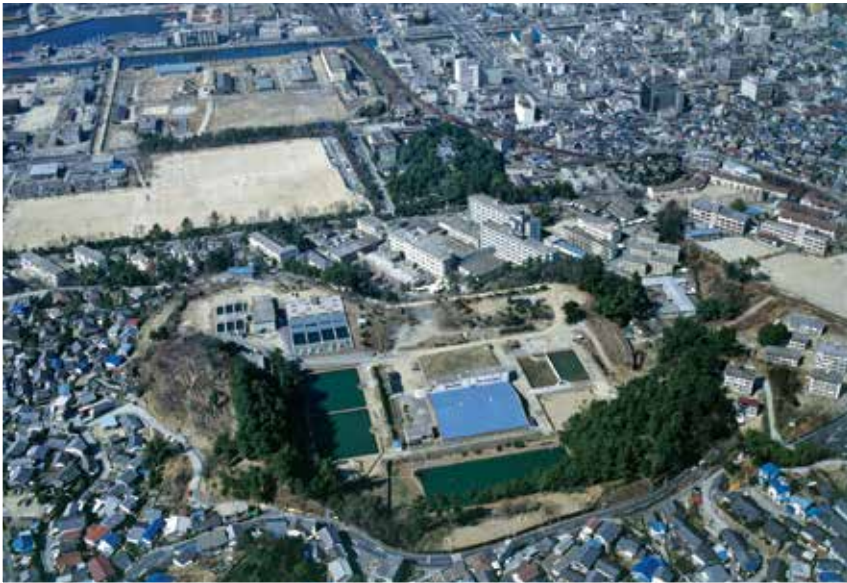
左中部に広島水道用水供給事業との共同施設が見える
