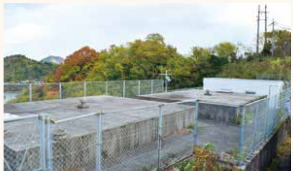
⑧豊町：大長御手洗配水池
