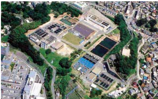
中央上部に工水沈殿池が完成している
