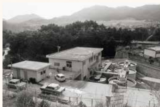
昭和46年に完成した焼山浄水場
