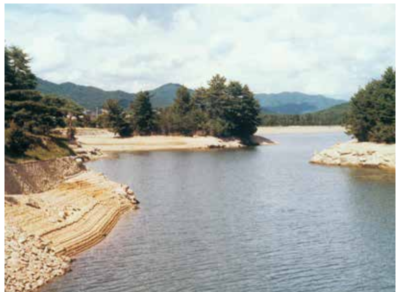
本庄水源地の渇水の状況(昭和53年)
