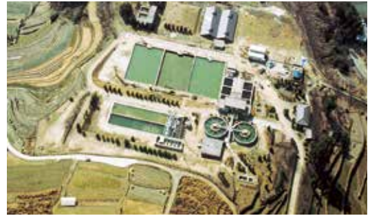
石内浄水場(昭和52年)
