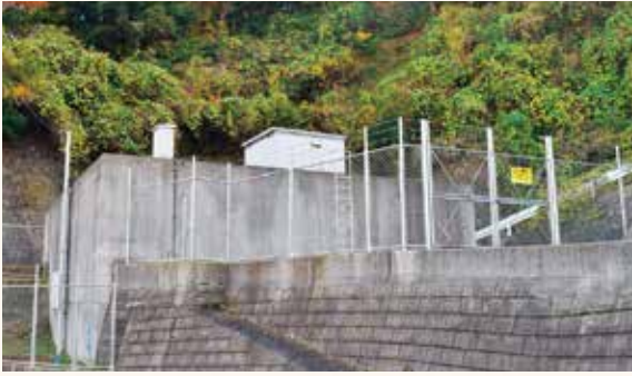
①下蒲刈町：林迫配水池
