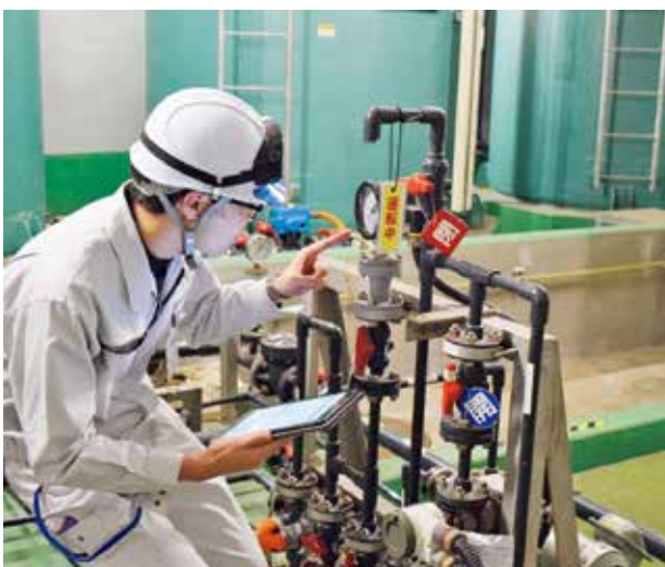
宮原浄水場等夜間・休日運転管理業務委託受託者の作業の様子
