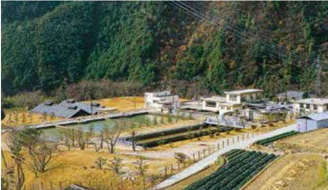
石内浄水場(昭和52年)
