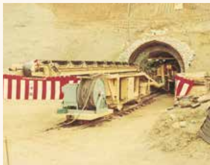
休山隧道配水池建設工事で使用されたトンネル・ボーリングマシン
