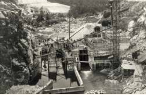
二級ダム：広島県が昭和18年に発電、灌漑、上工水に利用するため築造した多目的ダム(堰堤の建設)
