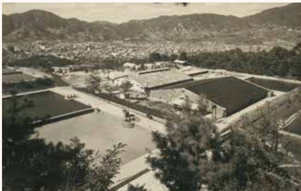
終戦後の水道施設(宮原浄水場)〈昭和29年〉
