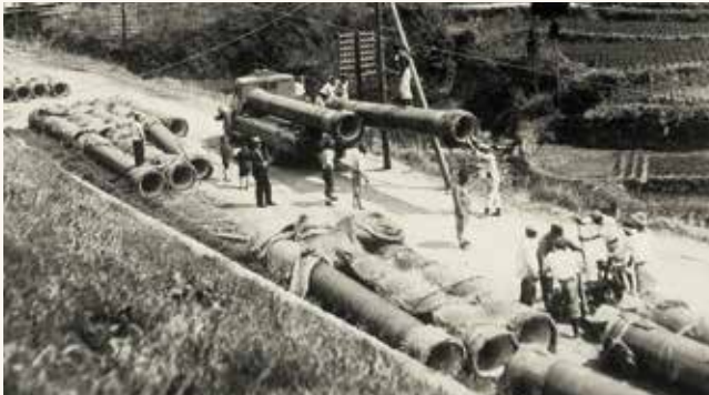
越畑線布設工事(昭和27年頃)
