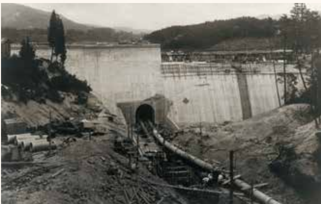
導水管布設工事(昭和17年7月)
