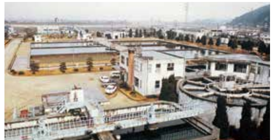
高速凝集沈殿池や管理棟
