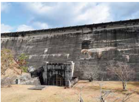
三永水源地堰堤
