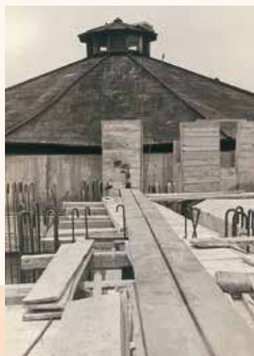
中山調整池築造工事(昭和30年頃)
