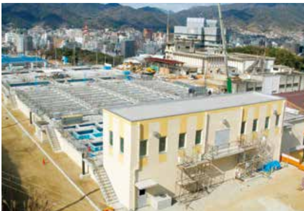
施設の統廃合により建設した宮原浄水場新浄・配水施設
