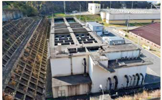
宮原浄水場内：現在の階層式工水沈殿池(平成16年3月完成)
