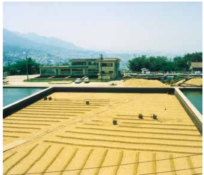
すき取り作業中の平原浄水場緩速ろ過池
