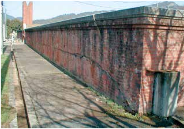
亀裂が入った平原浄水場低区配水池(平成13年)
