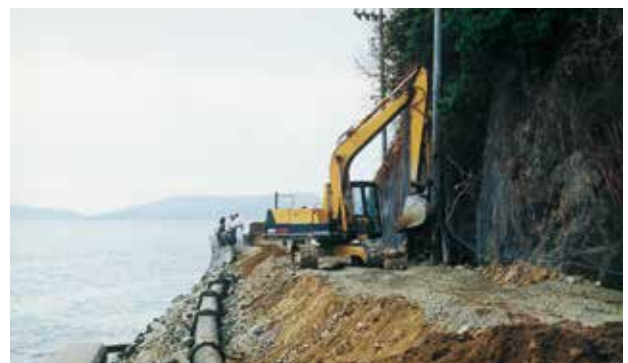
台風によって洗い流された配水管の復旧工事(平成3年)
