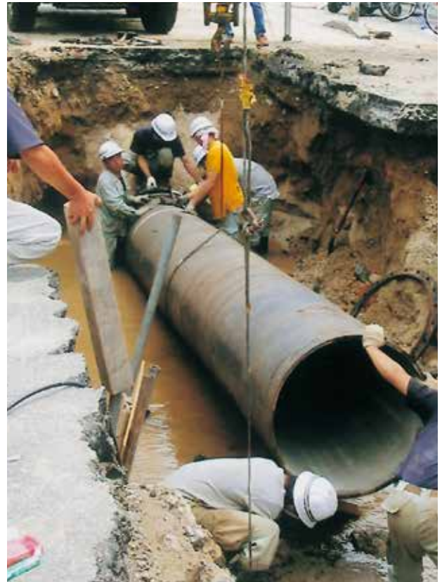
配水管（口径800mm）の修理の様子（平成16年）
