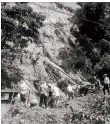
平原浄水場法面崩壊現場(昭和42年)
