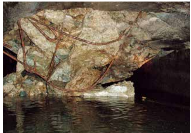
県の送水トンネル内の崩落場所(平成18年)
