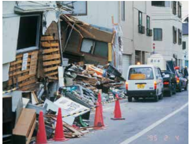
神戸市内の被害の状況(平成7年)
