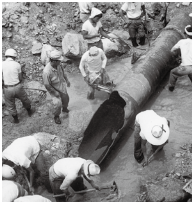
二河～宮原導水管が破損し復旧を急ぐ(昭和42年)
