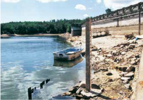
三永水源地の渇水の状況 干上がって堰堤の下部が見えている(平成6年)
