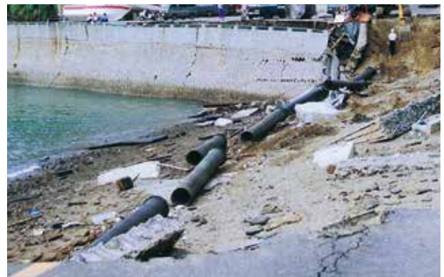
台風によって洗い流された配水管 護岸が崩壊している(平成3年)
