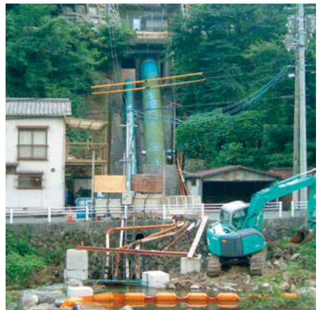
応急復旧対策(二河川から緊急取水し二河接合井にポンプアップ)(平成18年)
