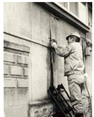
屋外の配管からの漏水を修理
