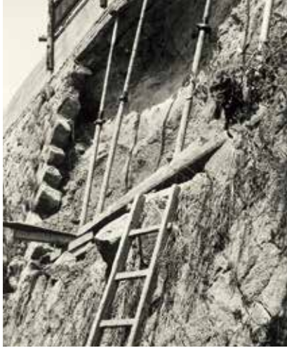
漏水した水が法面を洗い流す
