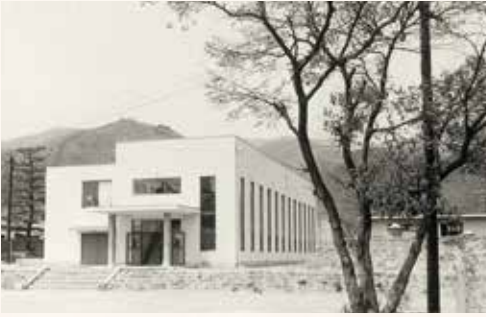
昭和42年頃の三坂地ポンプ所
