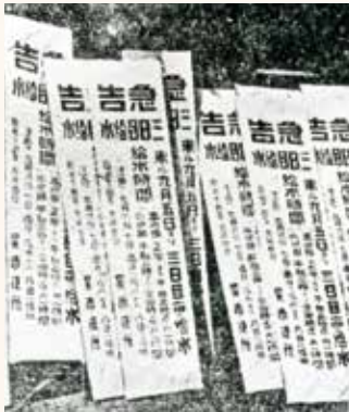
給水制限の告知板(昭和14年)
