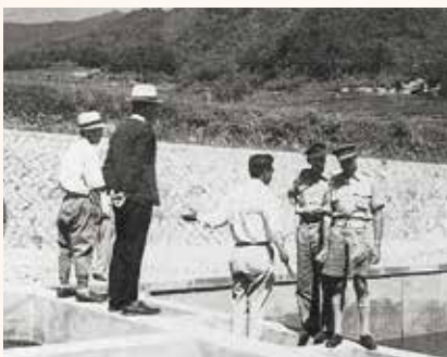
石内浄水場での連合軍による竣工検査〈昭和23年〉
