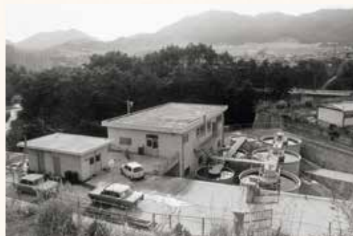
昭和46年に完成した焼山浄水場
