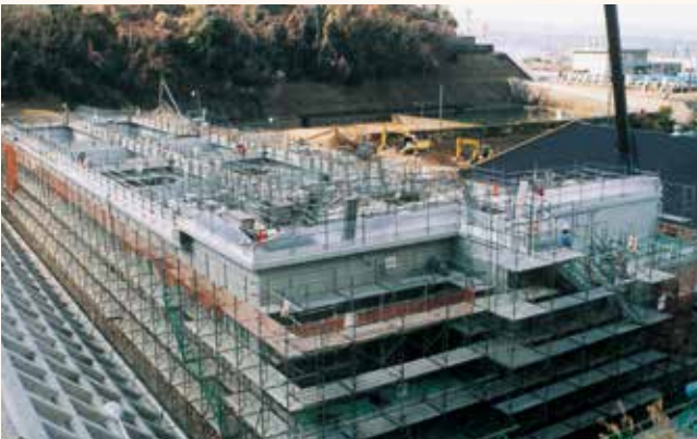
宮原浄水場内：完成間近の階層式工水沈殿池(平成16年1月)
