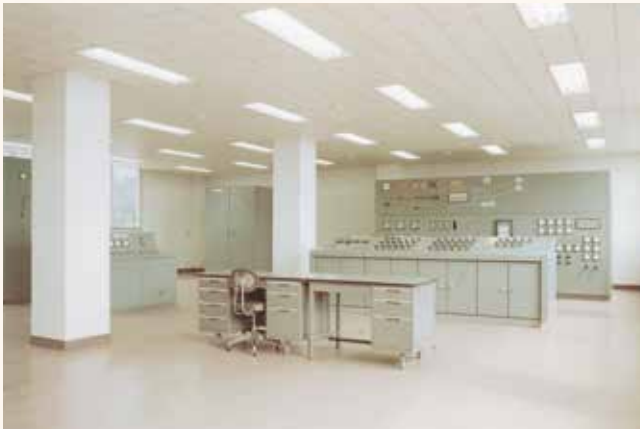
宮原浄水場管理棟内の中央監視施設(昭和47年)
