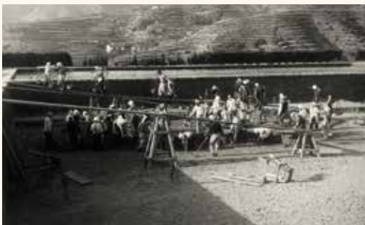
平原浄水場改良工事〈昭和27年〉
