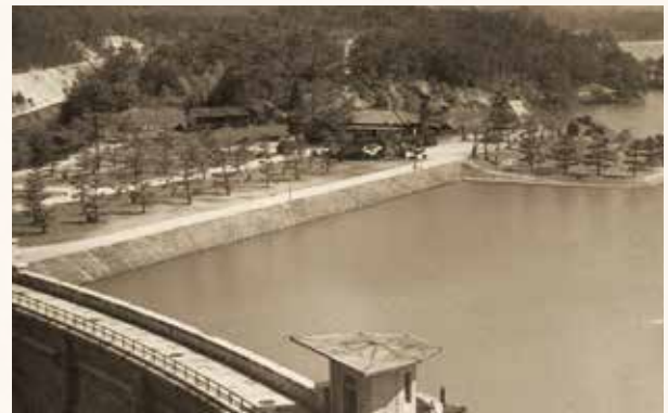
終戦後の水道施設(本庄水源池)〈昭和29年〉
