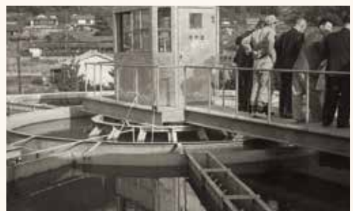
新築した戸坂浄水場高速凝集沈殿池(昭和32年)
