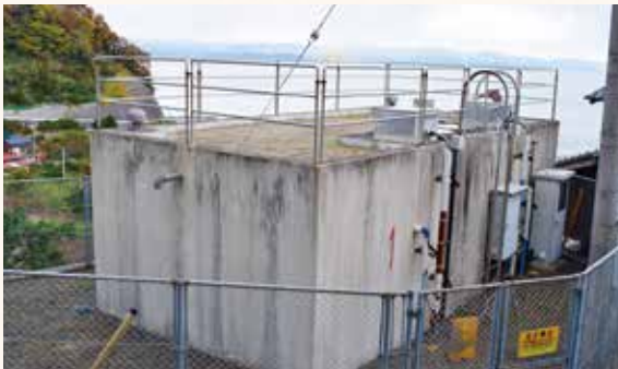
⑦豊浜町：山崎低区配水池
