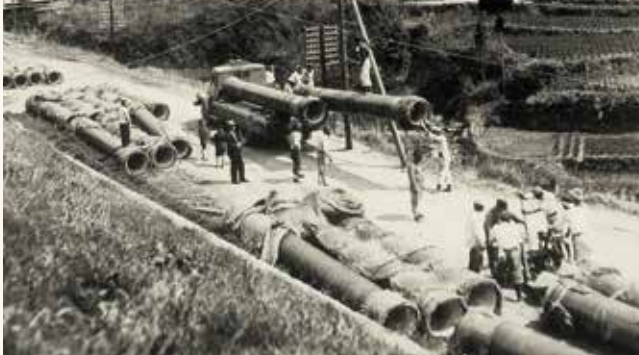
越畑線布設工事(昭和27年頃)
