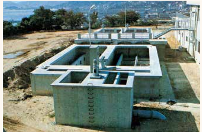
新築した宮原浄水場急速ろ過池(昭和47年)
