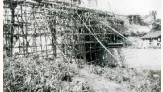
堰堤築造工事の足場の様子
