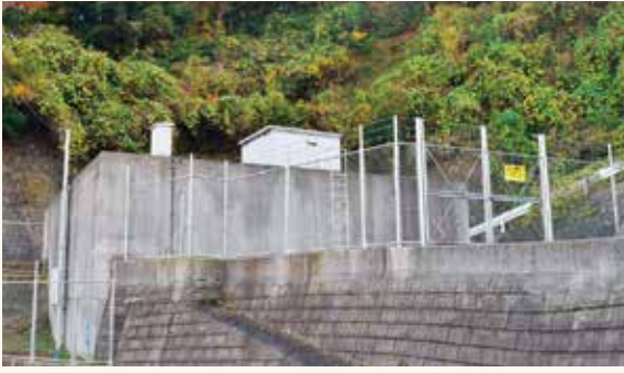
①下蒲刈町：林迫配水池
