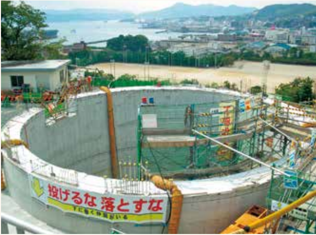
宮原浄水場内：新導水ポンプ所建設工事(平成22年9月)
