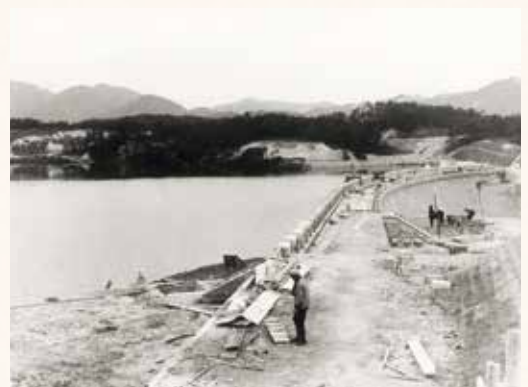
完成間近の堰堤<昭和17年9月>
