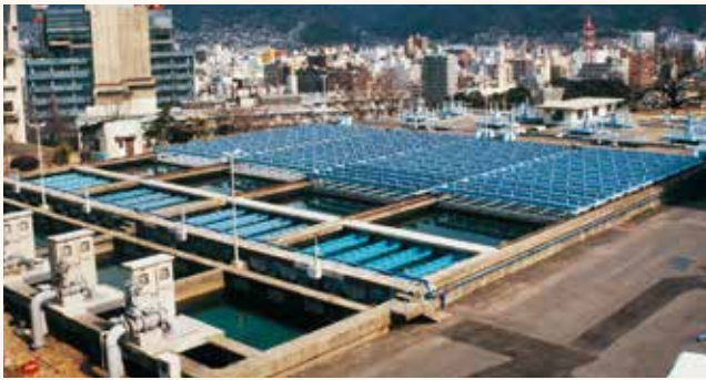
宮原浄水場内：改良した薬品沈殿池(平成9年)
