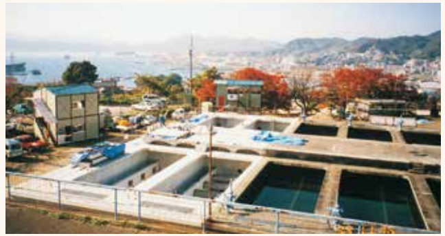
宮原浄水場内：拡張工事中の急速ろ過池(平成7年)
