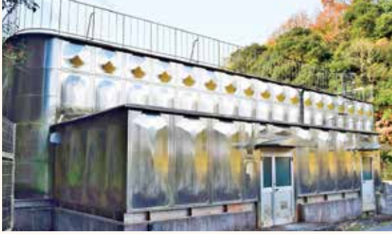
③音戸町：南隠渡配水池
