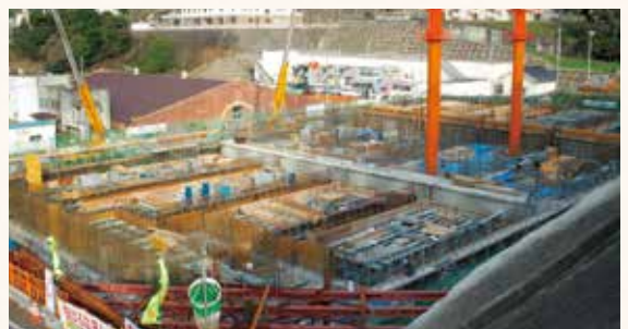
宮原浄水場内：新浄・配水施設の建設工事(平成22年3月)
