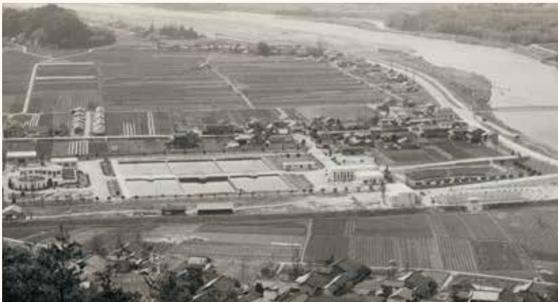
昭和36年の戸坂浄水場 左端に円形の高速凝集沈殿池が見える
