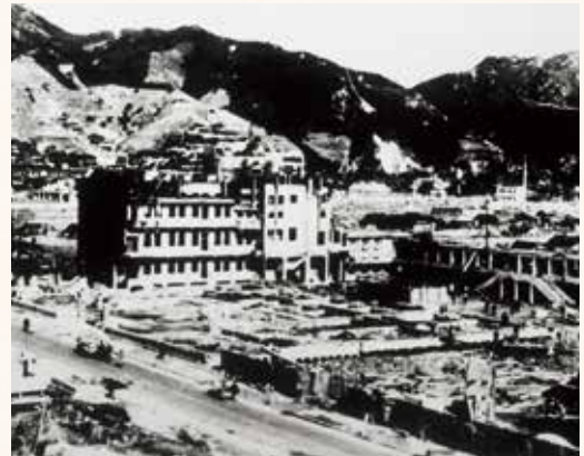
廃墟と化した市役所
