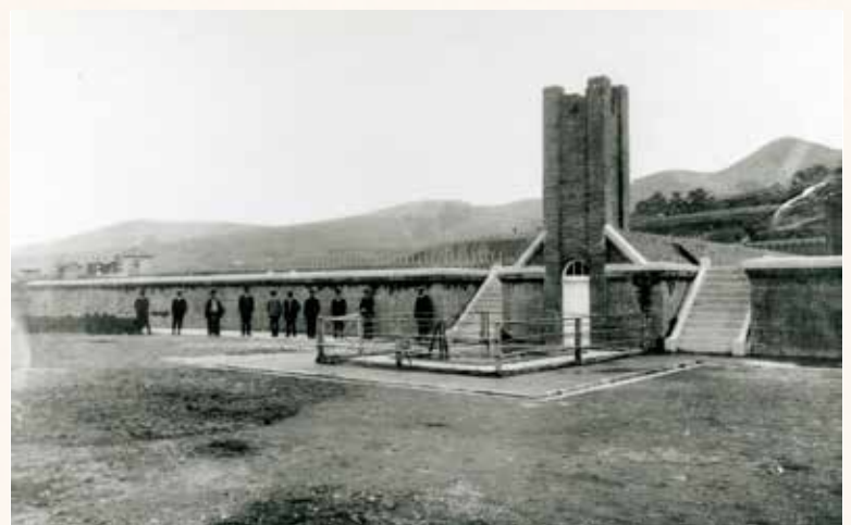
平原浄水場低区配水池(大正6年12月完成)
