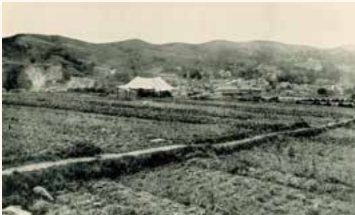
平原浄水場の起工式(大正4年7月)
