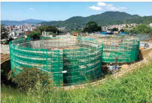
平原浄水場の跡地に建設中の平原低区配水池(平成27年9月)
