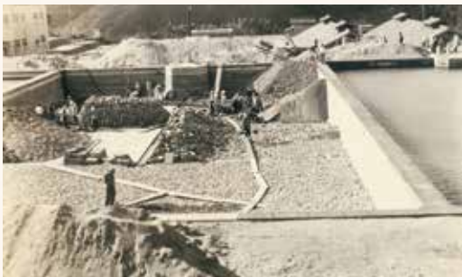
石内浄水場改良工事〈昭和23年〉
