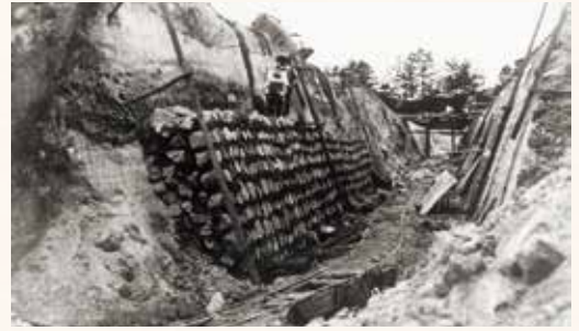
導水路側壁護岸工事<昭和16年7月>
