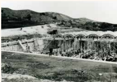
平原浄水場低区配水池築造工事(大正6年)
