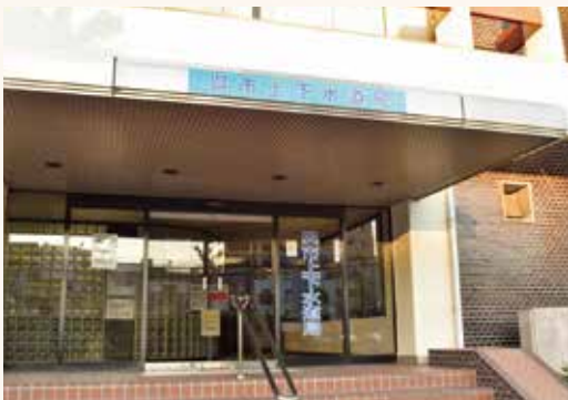
上下水道事業組織統合後の西中央庁舎
