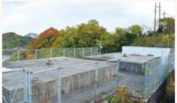
⑧豊町：大長御手洗配水池
