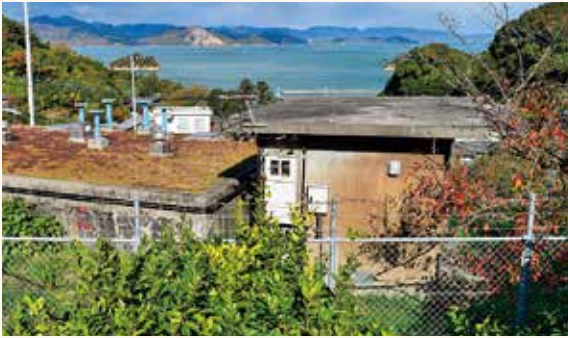
⑤蒲刈町：宮盛低区配水池
