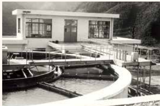
昭和47年頃の石内浄水場 新設した管理棟、高速凝集沈殿池などが見える
