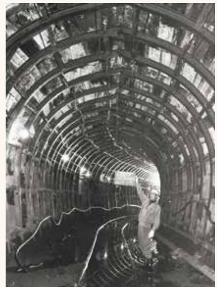
建設中の休山隧道配水池坑内
