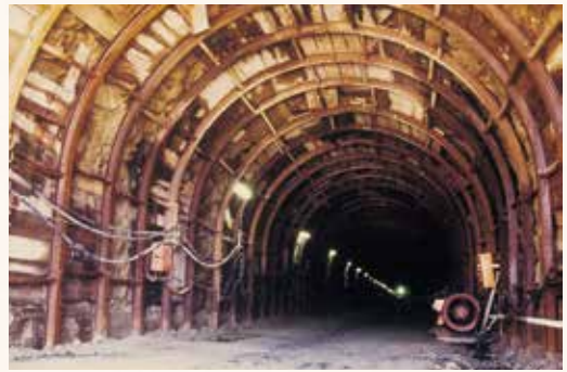
本庄隧道配水池建設中の坑内
