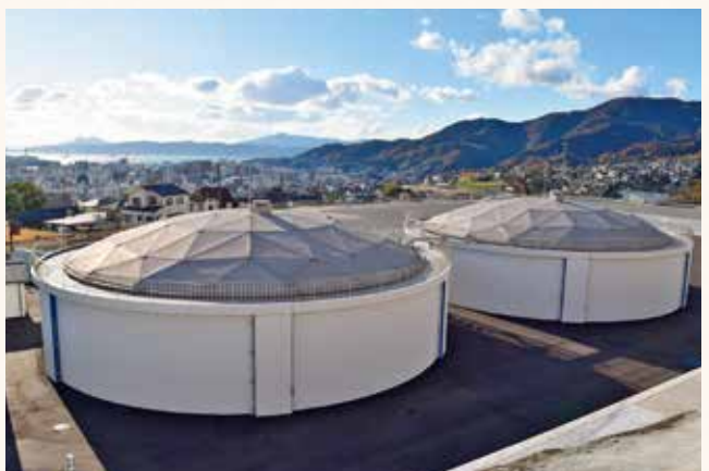
平原低区配水池(平成29年10月完成)
