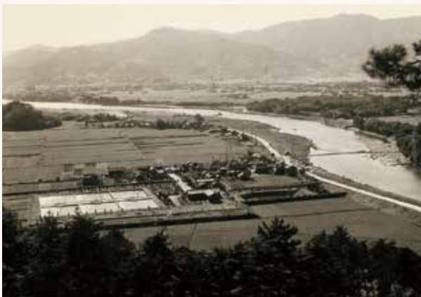
終戦後の水道施設(戸坂浄水場)〈昭和27年〉
