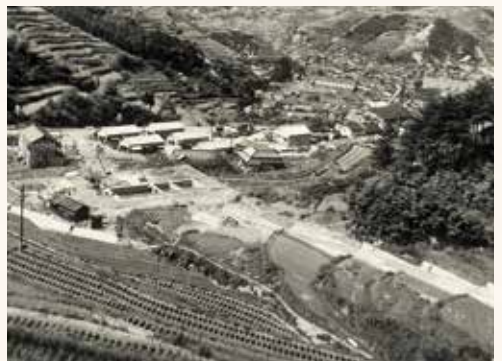
越畑減圧井建設工事(昭和27年頃)
