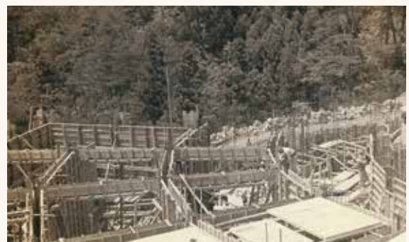
中山調整池築造工事(昭和30年頃)
