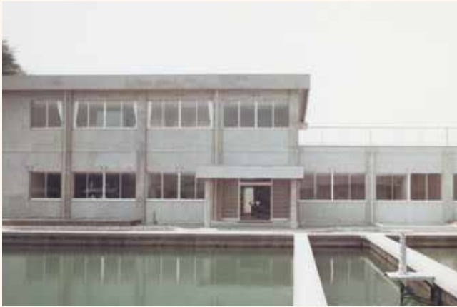
新築した宮原浄水場管理棟と薬品沈殿池(昭和47年)
