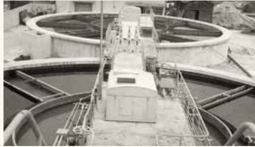
平原浄水場高速凝集沈殿池(昭和39年頃)
