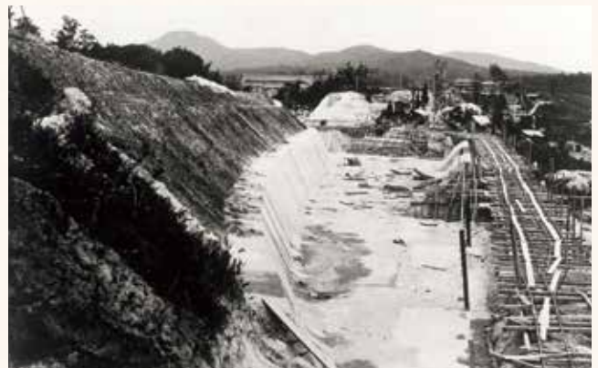
溢流堤築造工事<昭和17年5月>
