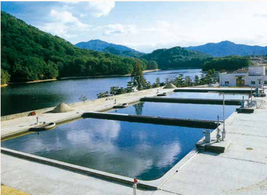
昭和61年頃の本庄浄水場(昭和56年完成)
