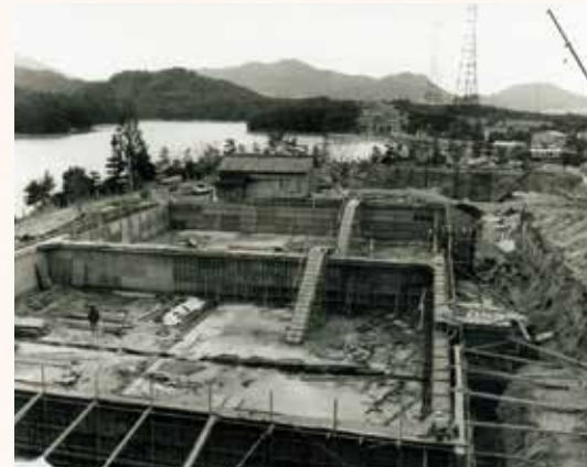
建設中の本庄浄水場(緩速ろ過池は当初2池であった)
