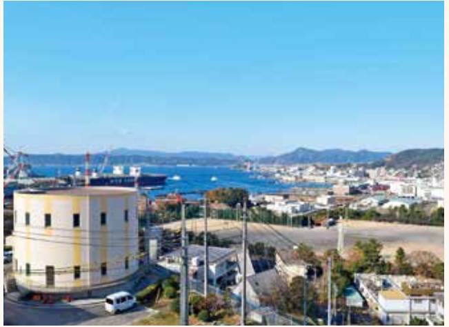
現在の宮原浄水場内：新導水ポンプ所(平成25年3月完成)
