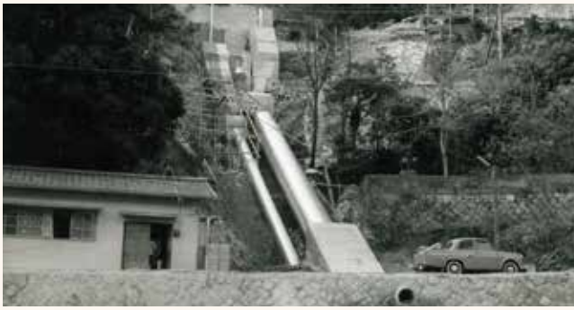
太田川東部工業用水道との共同事業(二河接合付近の様子)(昭和40年頃) ※一日最大取水量300,000立方メートル, 広島県工業用水道事業・呉市・安芸水道企業団及び江能水道企業団の4者共同事業
