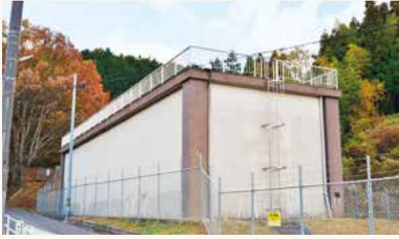
②川尻町：柳迫第2配水池
