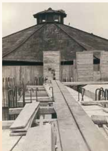
中山調整池築造工事(昭和30年頃)
