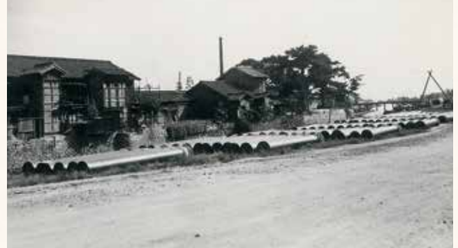
越畑線布設工事(昭和27年頃)
