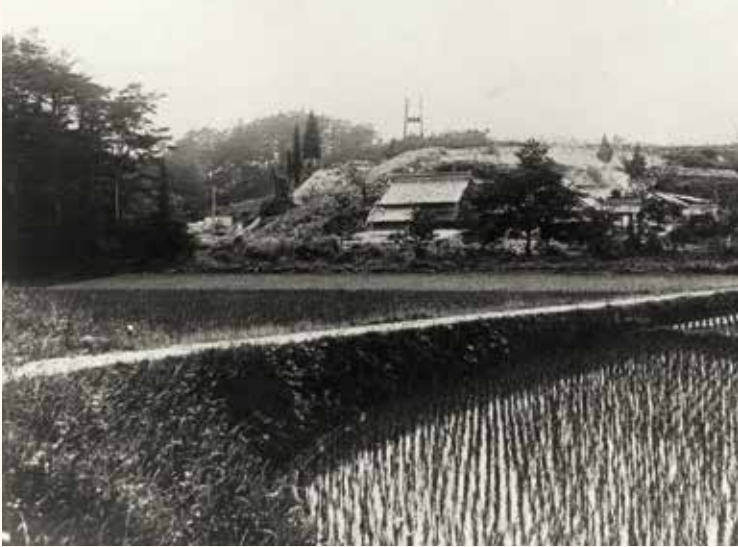
三本杉から左の松林までが堰堤築造予定地
