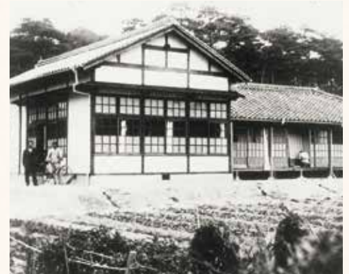
昭和18年当時の三永水源地管理事務所
