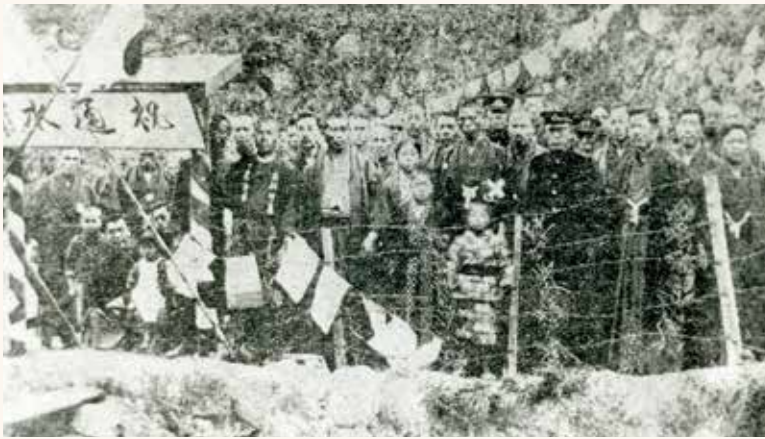
警固屋町に水道通水
