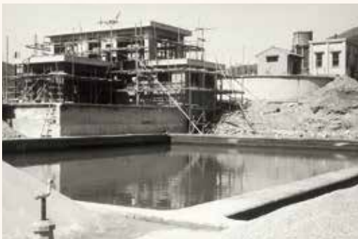
石内浄水場管理棟建設(昭和40年頃)
