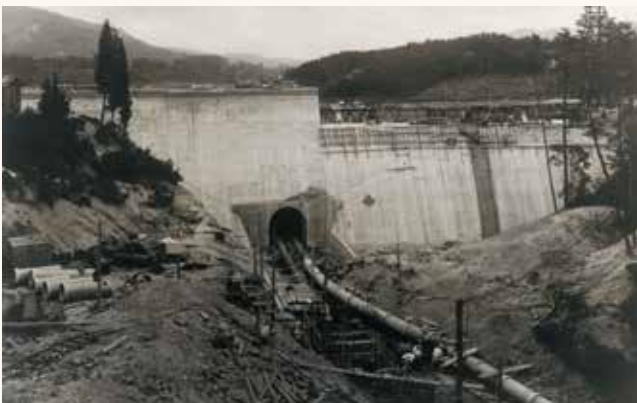
導水管布設工事<昭和17年7月>
