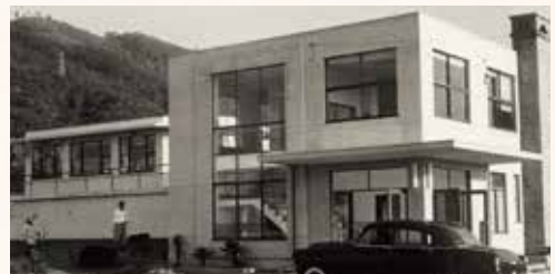
新築した戸坂浄水場ポンプ所(昭和32年)
