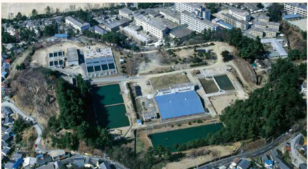
昭和52年頃の宮原浄水場(左上部に管理棟、着水井、薬品沈殿池、急速ろ過池等が、中央部に中区ポンプ所が見える)
