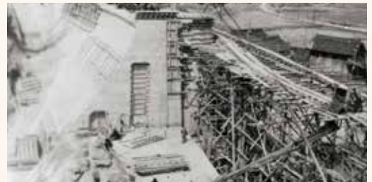
堰堤築造工事
