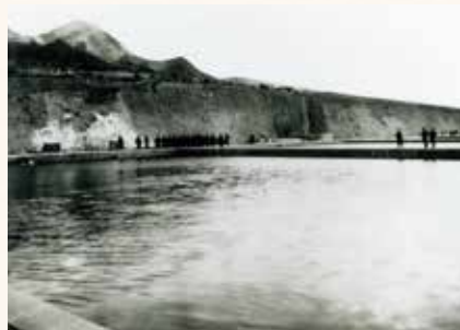
平原浄水場緩速ろ過池(大正7年3月完成)
