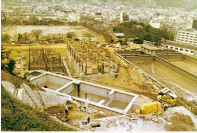
宮原浄水場内：広島水道用水供給事業との共同施設 (着水井，管理棟，急速ろ過池など)を建設(昭和47年)
