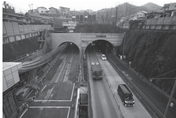
休山新道4車線化工事
