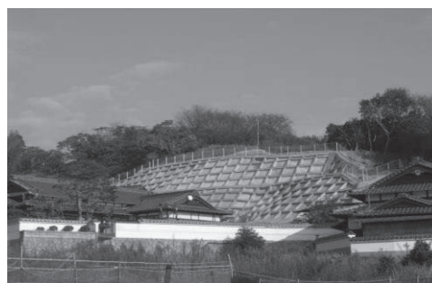
急傾斜地崩壊防止工事（施工後）
