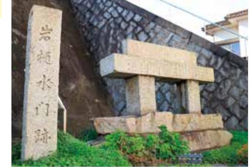
広村大新開干拓工事のために岩を削り取って樋門(通水門)を造り、汐の干満を利用して生活污水等の悪水を海に流すため建造され元禄2(1689)年に完成した。
