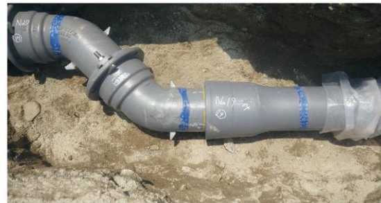
▲耐震管の布設状況(ダクタイル鋳鉄管)
