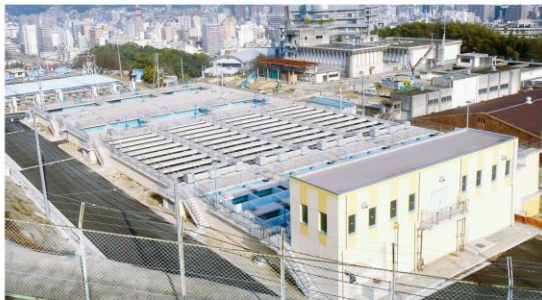
▲耐震化した宮原浄水場の浄水施設
