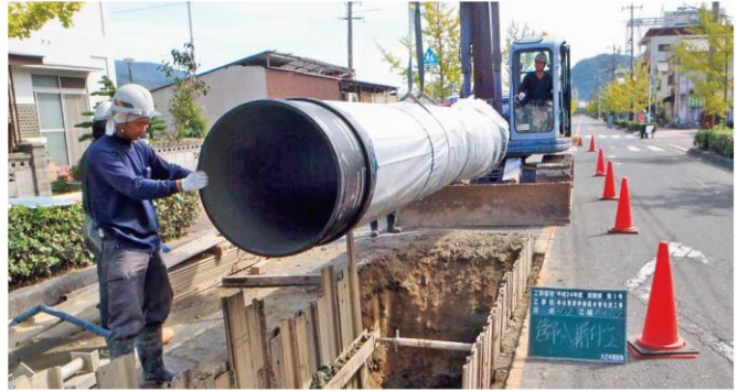
▲耐震管の布設状況
