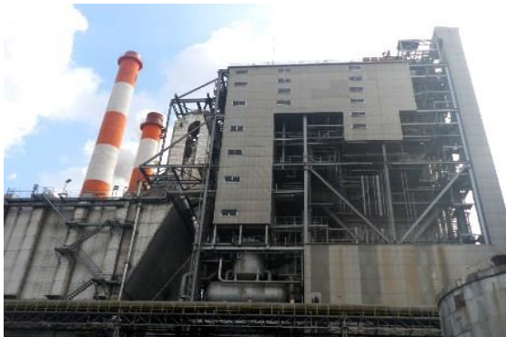
回収ボイラー
