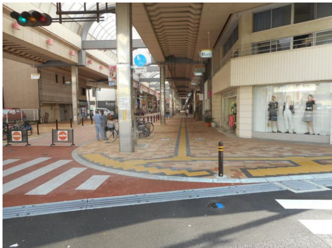
視覚障害者誘導ブロック設置
