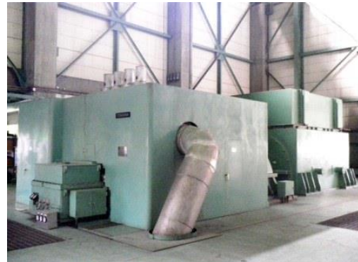
タービン発電機
