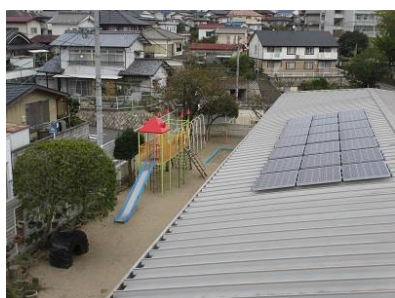
太陽光パネル（4.4kw）
