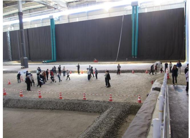
当最終処分場は、埋め立てる場所を屋根で覆うクローズド（覆蓋型）で、埋立物の飛散や悪臭の拡散を防ぎ、雨水が流入しないよう周辺環境に配慮した設計になっています。
