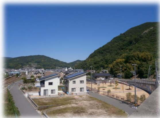
土地区画整理事業で造成された住宅地
