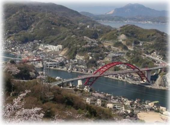
音戸大橋と第二音戸大橋
