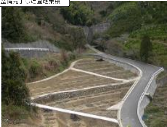
整備完了した園地集積
