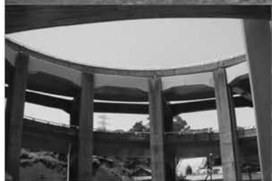
音戸のうず潮のようにクルクルまわるラセン式高架橋。半径24m、設計速度30キロ、2周半で地上へ降りる。クルクルの中は現在町営駐車場になっている。
