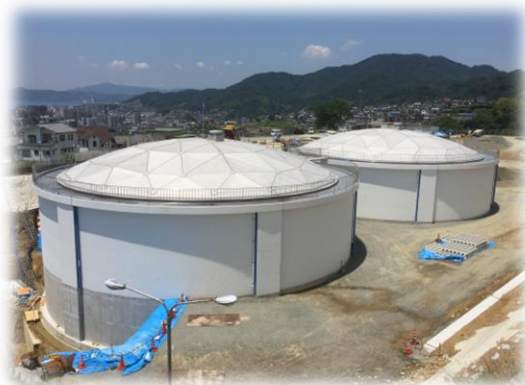
平原低区配水池 (H29 年度完成予定)
