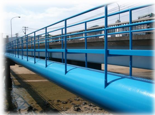
水管橋の塗装（二河川・かもめ橋）
