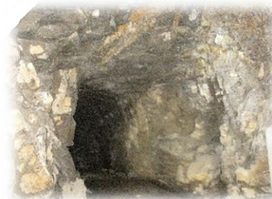
本庄導水線路 第1 隧道内
