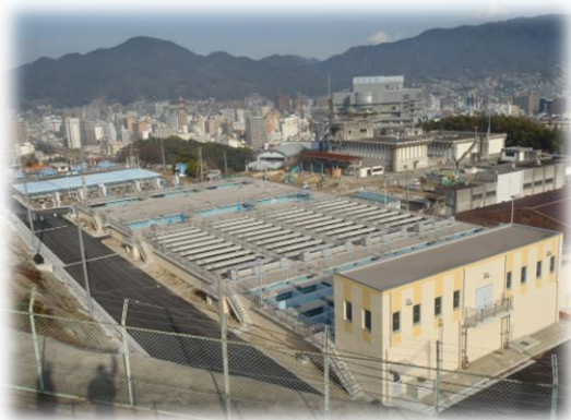
宮原浄水場浄・配水施設 (H25.4.1 供用開始)
