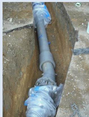
GX型ダクタイル鋳鉄管 (ポリエチレンスリーブ被覆前)
