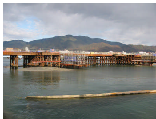
建設中の広第2大橋
