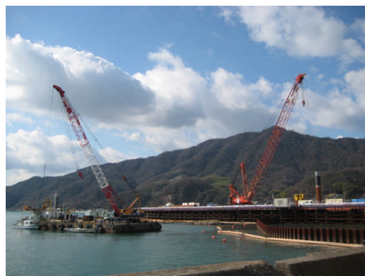
建設中のマリノ大橋
